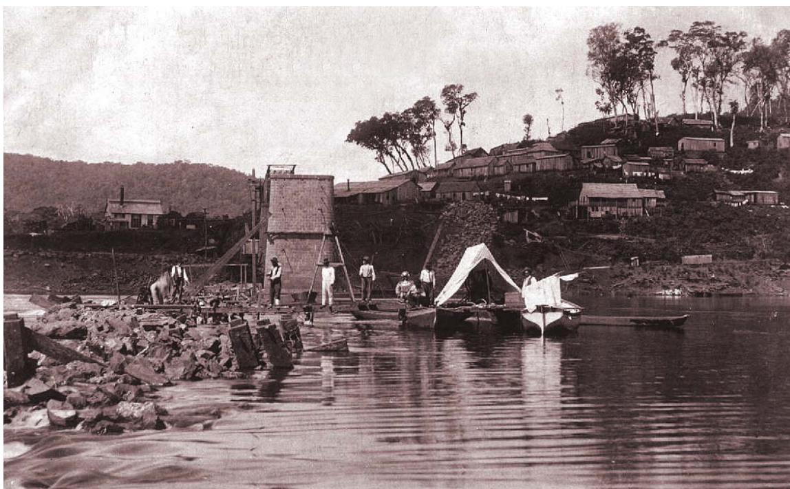
Imagem 5: Ponte sobre o Rio Uruguai destruída pela enchente em 1911. Fonte: ABPF/PR.
