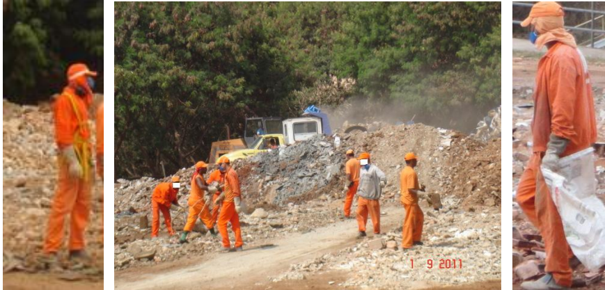
Figura 2 - Proteção individual dos trabalhadores nas ARs
