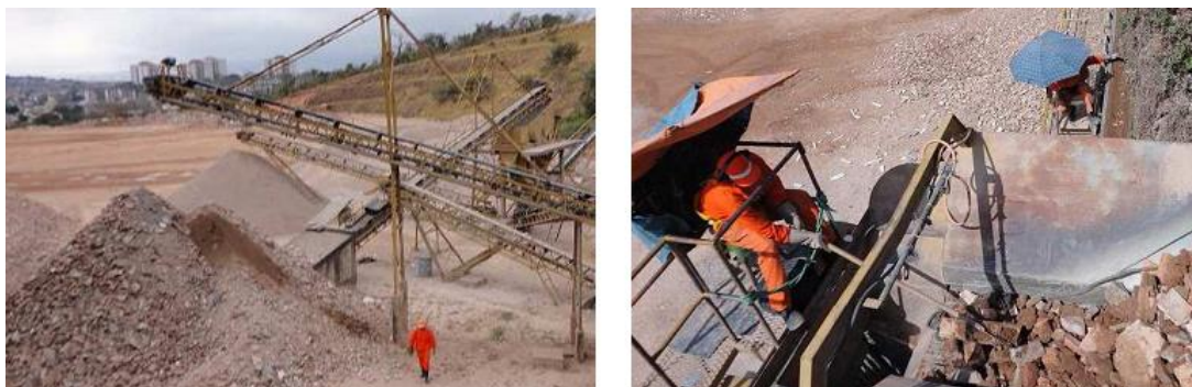
Figura 4 - O trabalho nas correias de beneficiamento da AR na BR-040
