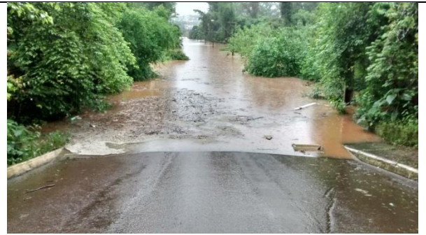
Ponte sobre arroio Saraquá Data: 10/10/2015
