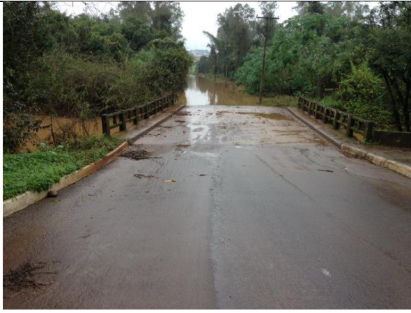
Ponte sobre arroio Saraquá Data: 16/07/2015
