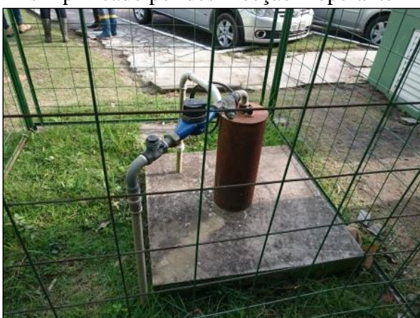
Figura 5.16: Poço em ótimas condições de conservação
