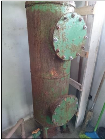
Figura 5.2: Sistema de tratamento com filtração
