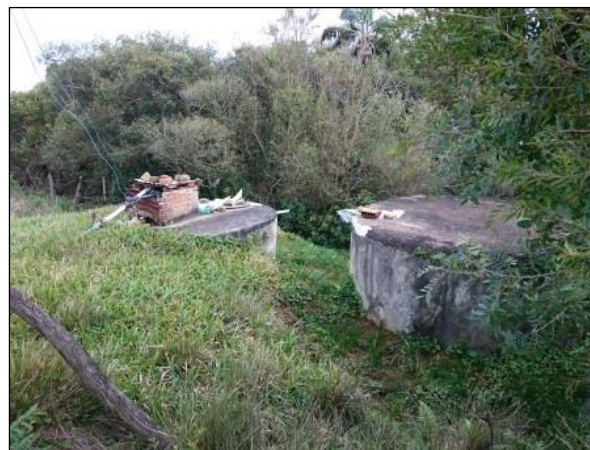
Figura 5.8: Captação em manancial subterrâneo raso
