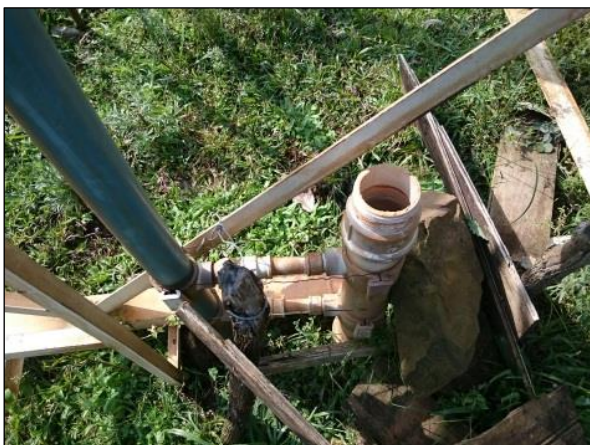
Figura 5.14: Sistema de tratamento simplificado por desinfecção inoperante
