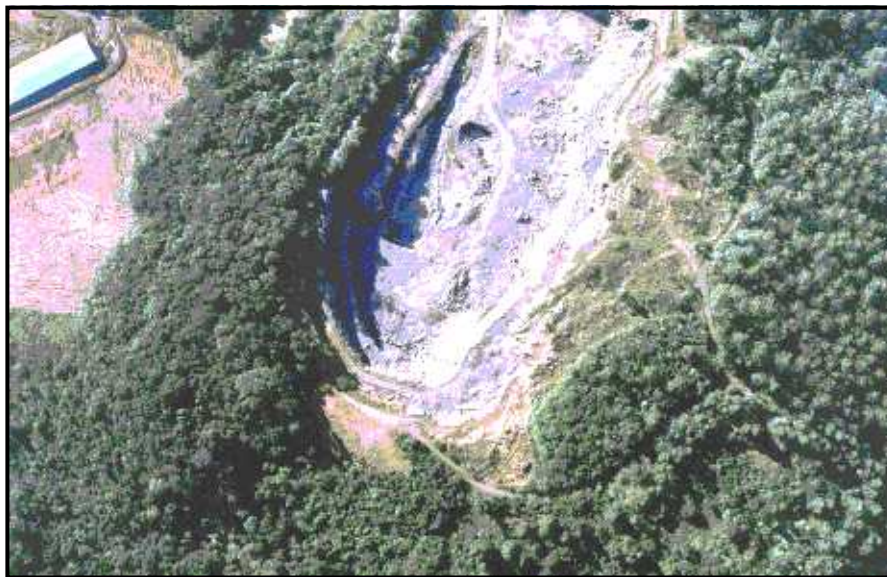
Figura 4.3 - Pedreira da COMUR, bairro Roselândia, Formação Serra Geral
