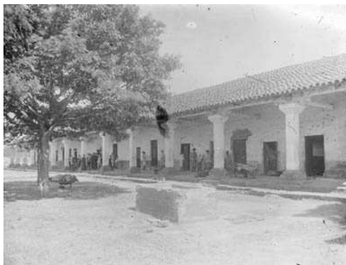
FIGURA 4 - Colégio do antigo povo de São Luiz Gonzaga antes da demolição, na década de 1930. ANS.
