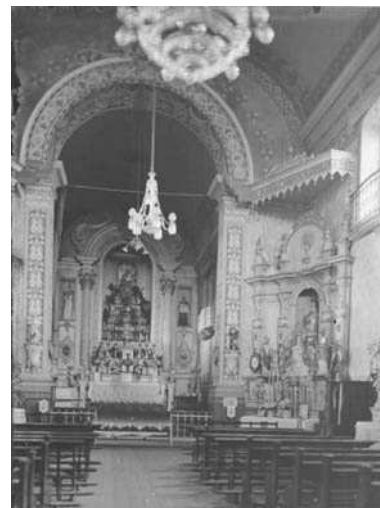
Fotografia 10 - Interior da Igreja do Rosário, demolida após a notificação. ANS
