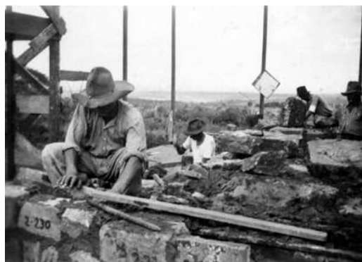
Fotografia 67 - Remontagem das alvenarias de pedra durante a obra do SPHAN, executada por Mayerhofer entre 1938 e 1940. ANS.
