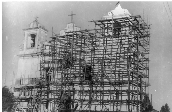
FIGURA 85- Obras na Igreja N. S. de Viamão [s.d.]. Arquivo IPHAN/RS. Foto: Edegar B. da Luz.
