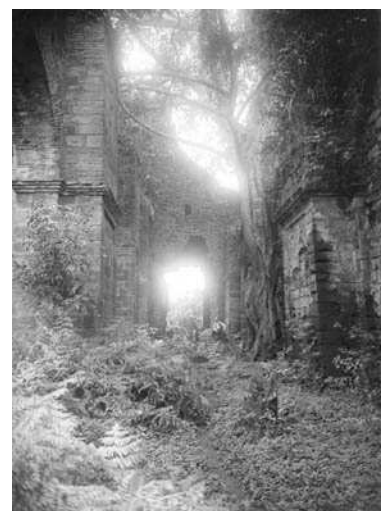
Fotografia 3 – Ruínas da igreja antes das obras [ca.1920]. ANS
