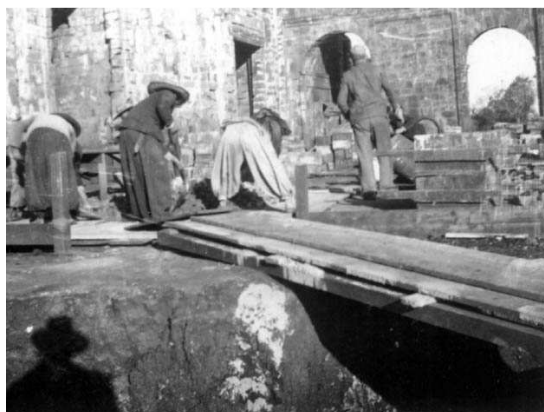
FIGURA 55 - Equipe de operários na obra de consolidação executada por Lucas Mayerhofer, entre 1938 e 1940. ANS.
