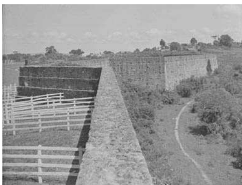
FIGURA 26 - Muros do Forte de Caçapava. Russins, 1952. ANS.
