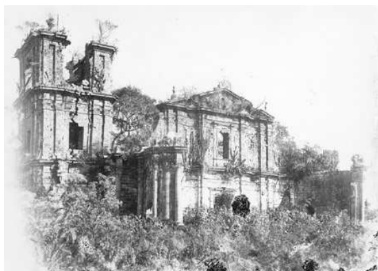
Fotografia 51 - As ruínas da Igreja de São Miguel Arcanjo antes das obras de estabilização. Arquivo IPHAN/RS.
