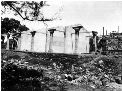
Fotografia 58 - O início da construção do Museu das Missões. ANS.
