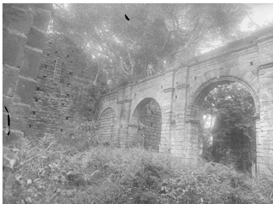
Fotografia 79 - A situação da nave antes das obras de consolidação do governo do Estado [s.d.]. ANS.
