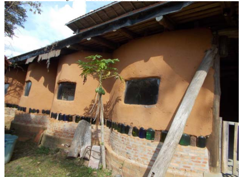
Figura 7. Edifício da sala de reuniões, detalhe da fachada.
