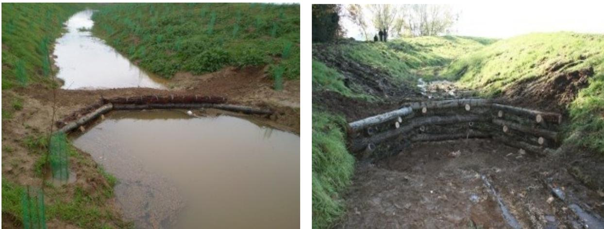
Figura 19- Técnicas de paliçada em cursos d'água. Fonte: Engenharia Natural, 2007.
