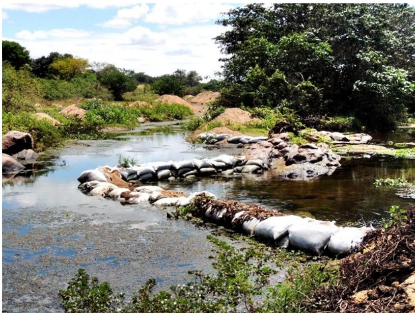
Figura 20– Paliçada/barramento de sacos de areia para redirecionamento do fluxo d'água. Fonte: Naturalea, 2012.
