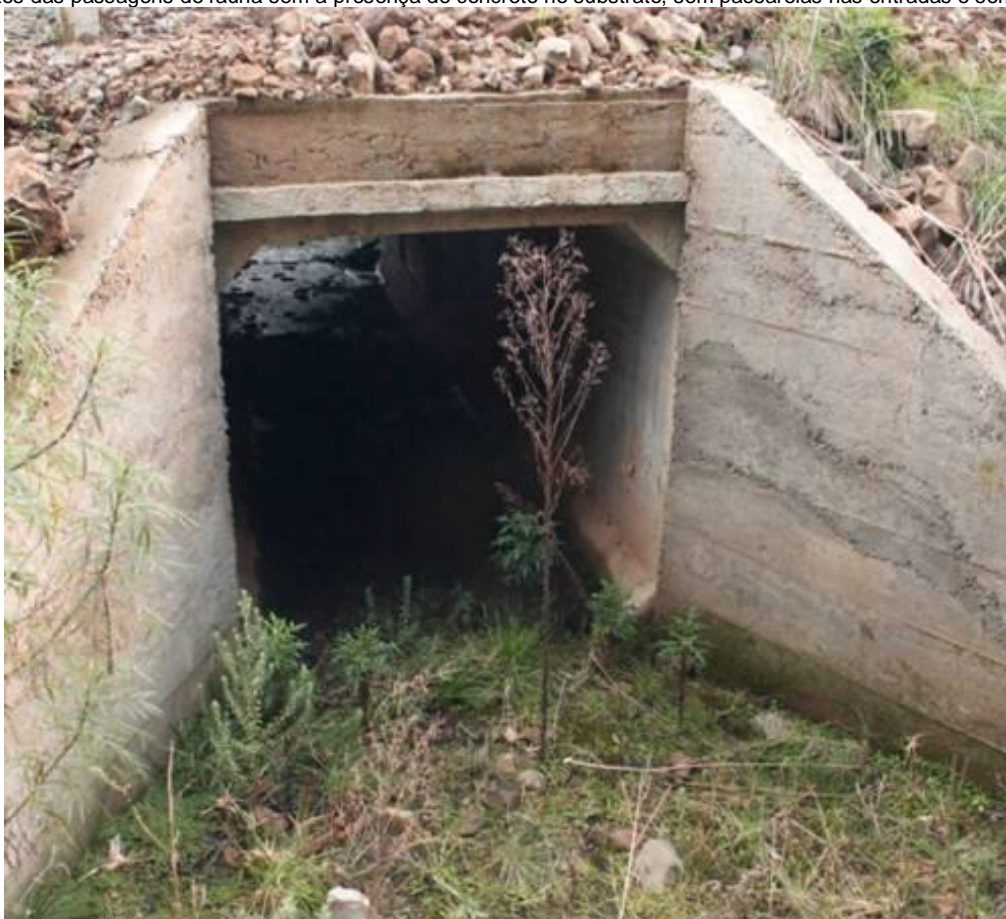
Anexo 5 Ductos das passagens de fauna sem a presença de concreto no substrato, sem passarelas nas entradas e sem água (SPSA)
