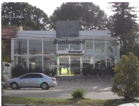
Figura 11 - Loja Bontempo, na Av. Nilo Peçanha - edifício contemporâneo
