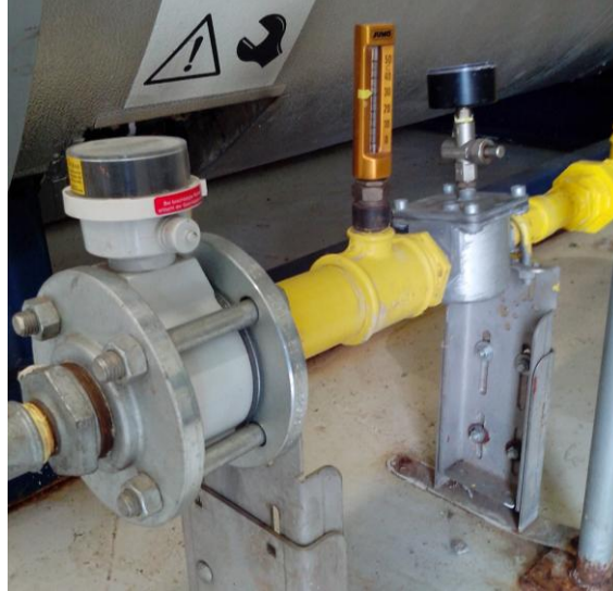
Figura 23 – Instrumentos para medição de volume de gás natural consumido.
