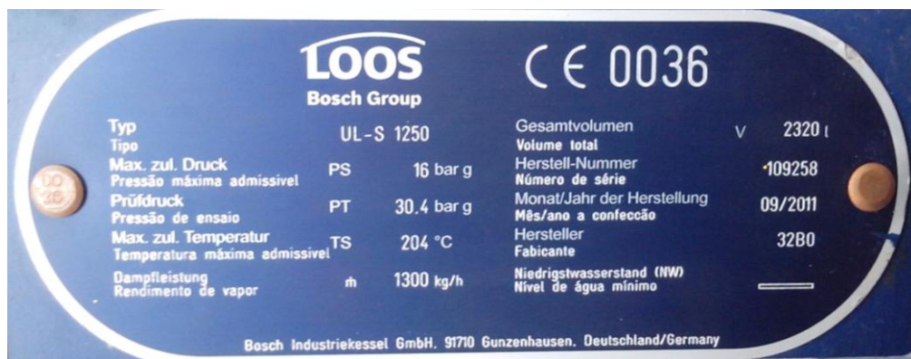
Figura 21 – Placa de identificação e dados da caldeira.
