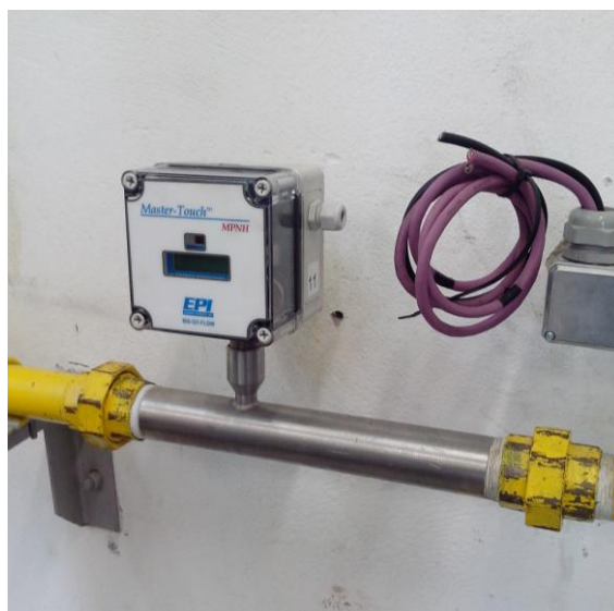
Figura 24 – Medidor mássico para determinar consumo de gás natural.
