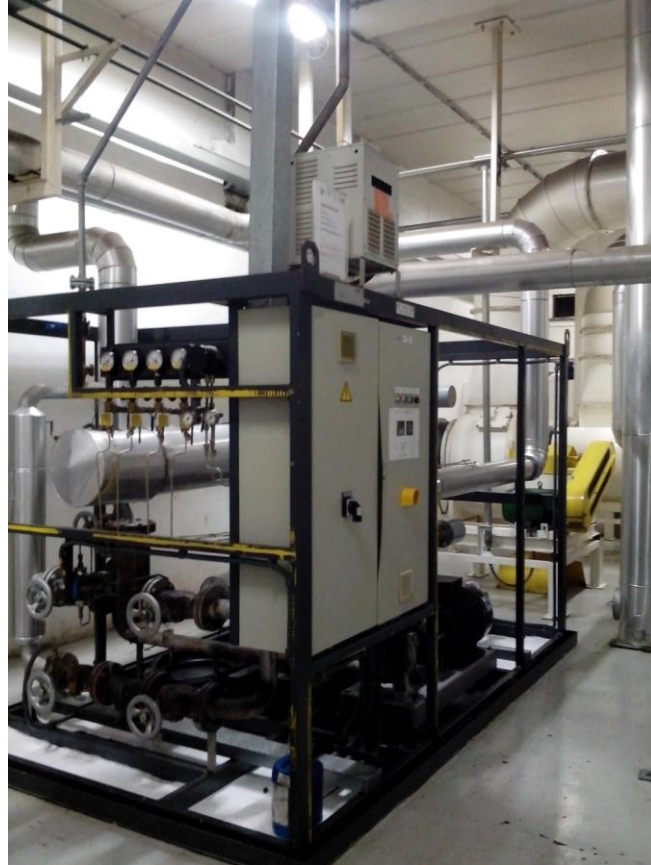
Figura 17 – Circuito de aquecimento de óleo térmico na Fitesa Gravataí.
