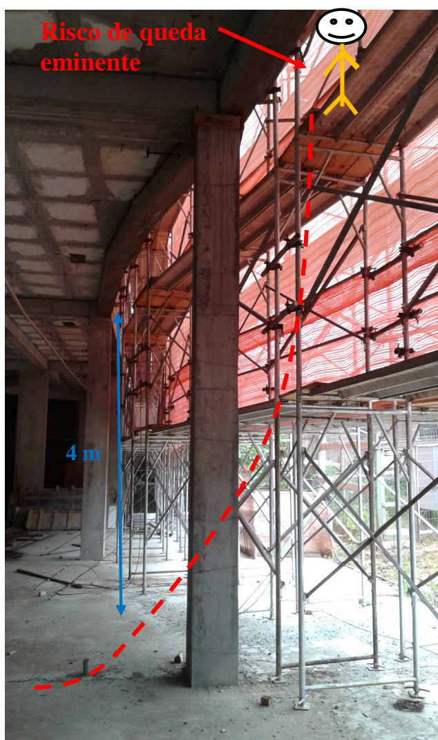
Figura 16 – Risco de queda na face interna
