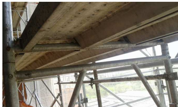
Figura 15 – Instalação de piso metálico
