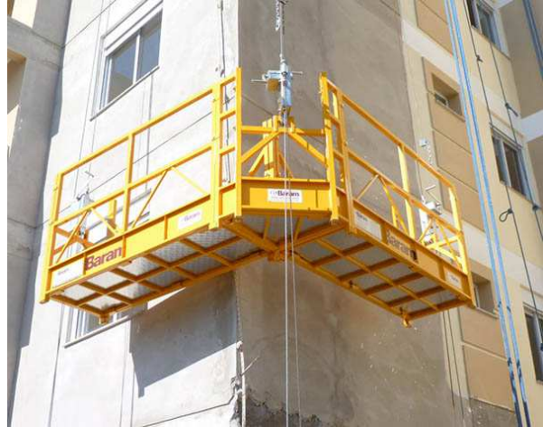
Figura 7 – Andaime em balanço para cantos
