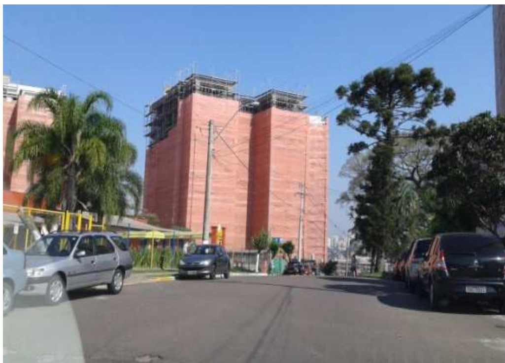
Figura 12 – Modelo 01 de obra visitada
