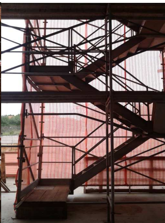
Figura 18– Torre de acesso
