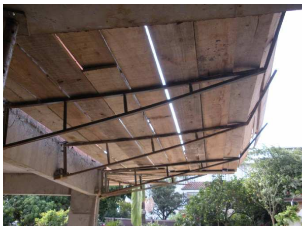
Figura 8– Plataformas de Proteção
