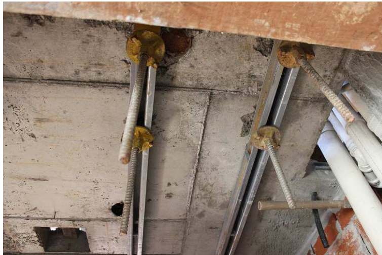
Figura 27 – Fixação do AF na laje
