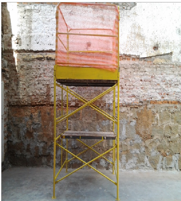
Figura 2 – Andaime simplesmente apoiado
