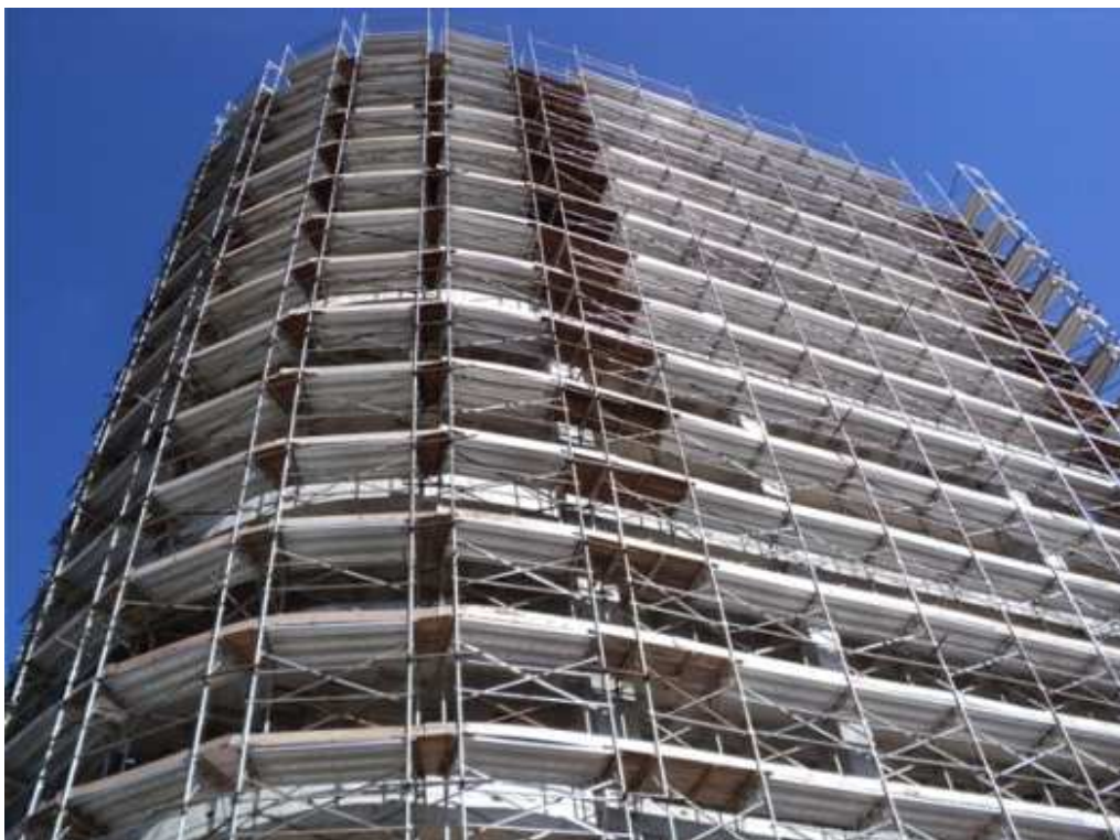
Figura 13 – Modelo 02 de obra visitada
