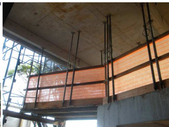
Figura 9– Sistema de Proteção Periférico
