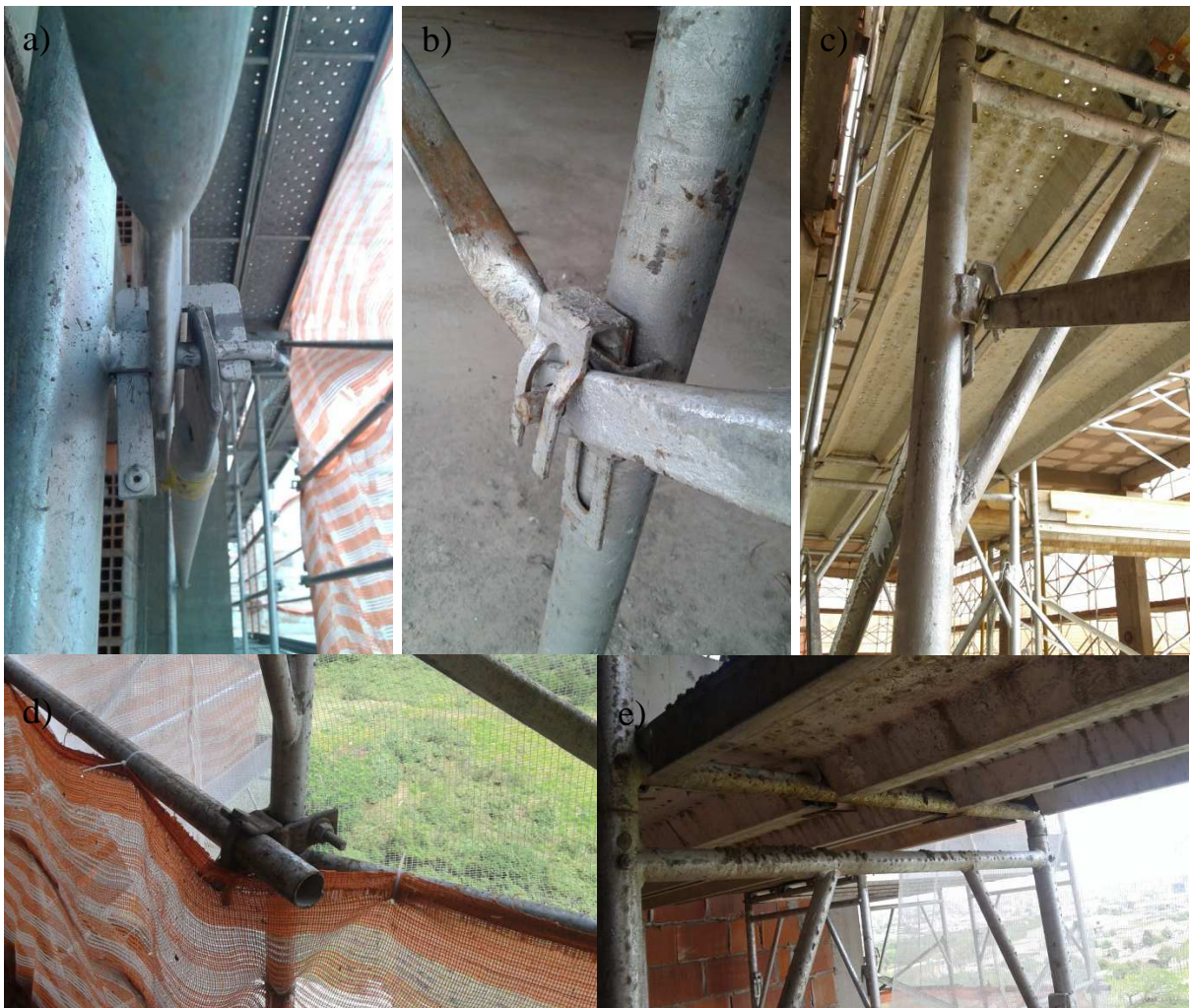
Figura 21 – (a), (b) e (c) sistema de pinos ; (d) fixação com braçadeiras e parafusos; (d) técnica de fixação que impede o tombamento; e) piso com encaixe.
