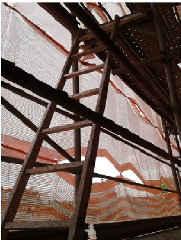
Figura 17 – Escada incorporada a estrutura
