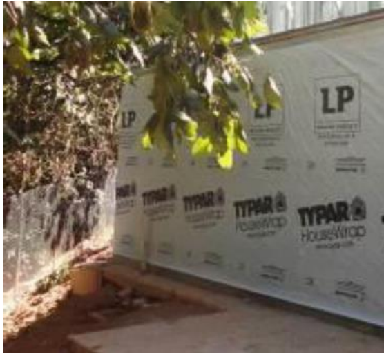
Figura 10– Fixação da manta impermeável nas placas OSB
