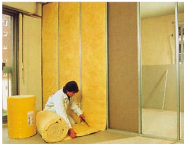
Figura 12 – Aplicação da lã de vidro em paredes internas
