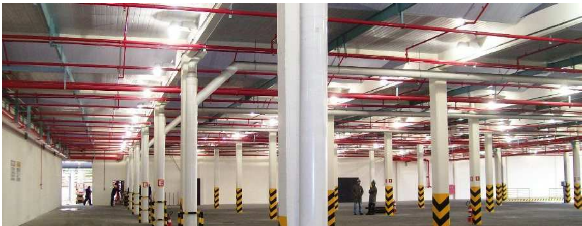
Figura 10– Rede hidráulica de distribuição
