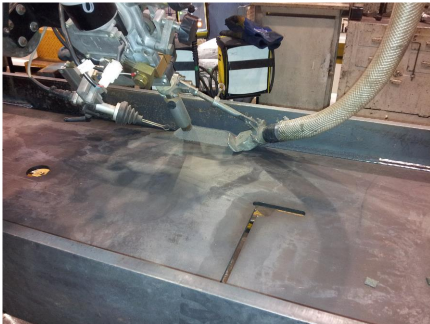
Figura 6 - Soldagem por arco-submerso de uma viga de veículo rodoviário. Fonte: Randon Implementos S.A. (2014).
