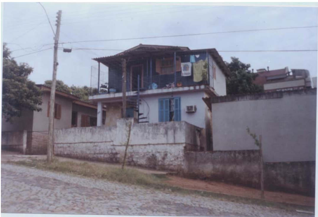
Foto 9. Visão dos puxados construídos todos no mesmo terreno.
