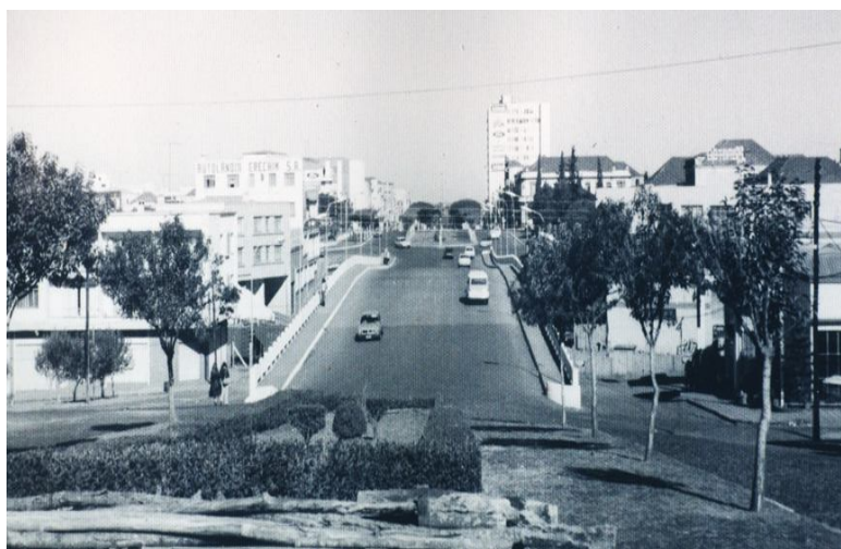
Figura 4.33: Vista do Viaduto Ruben Berta, década de 1960 Fonte: Arquivo Histórico Municipal
