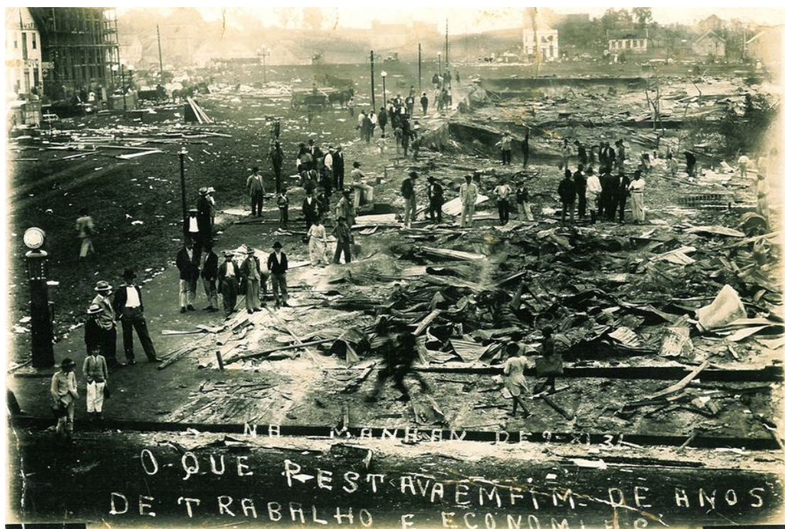
Figura 4.22: Incêndio de 1931 Fonte: Acervo de Carlos Funfgelt
