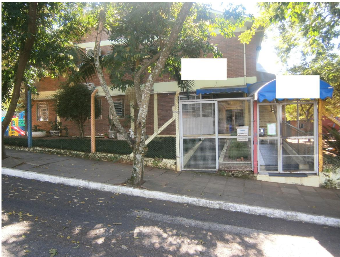
Figura 1 – Fachada da EMEI Pesquisada
