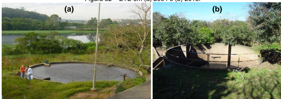
Figura 52 – ETE em (a) 2004 e (b) 2013.
