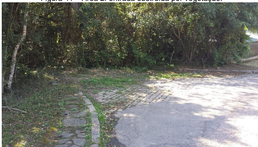
Figura 41 – Área 2: entrada obstruída por vegetação.
