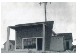
Figura 117. Usina geradora de energia elétrica.s/d.
