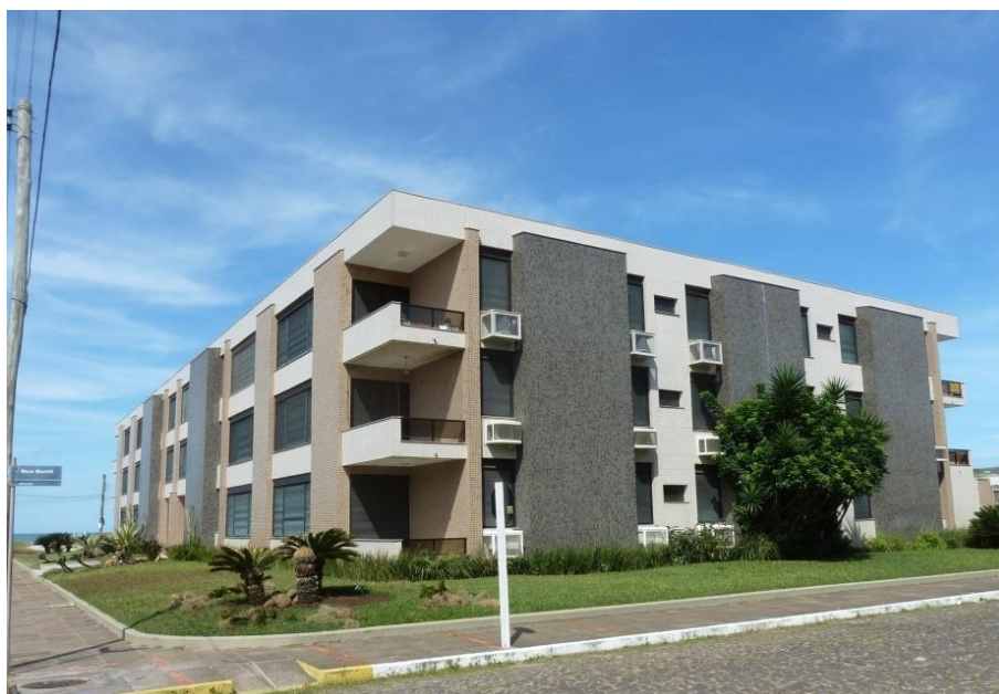
Figura 211. Edifício Fragata, na esquina da Beira Mar com Central. Julho 2015.
