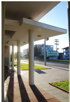
Figura 204. Marquise do acesso pela avenida Central. Maio 2014.
