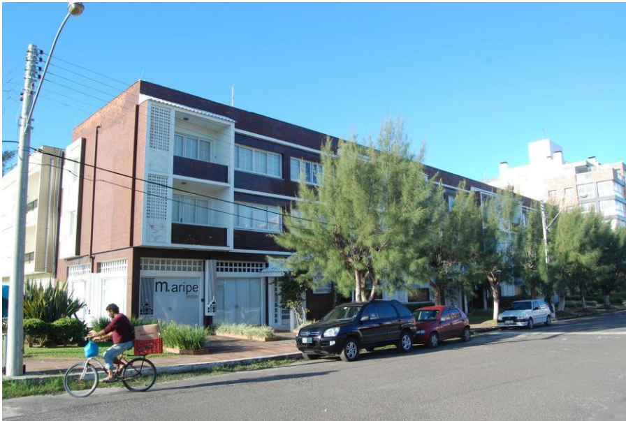
Figura 208. Edifício Netuno, um dos primeiros a ser construído na Praça Central. Julho 2015.
