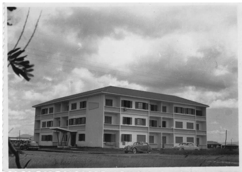
Figura 158. Edifício Paquetá, na esquina das avenidas Paraguassu e Central, antes da ampliação. Detalhe da marquise de proteção do acesso, que dá o "ar moderno".
