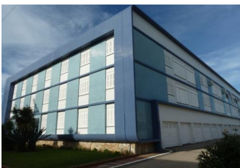
Figuras 212 e 213. Edifício Pérola. Julho 2015.
