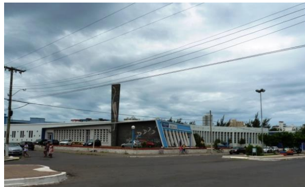
Figura 73. O prédio da SAT ainda íntegro, estruturando a esquina da Rua da Igreja. Foto de fevereiro de 2013.
