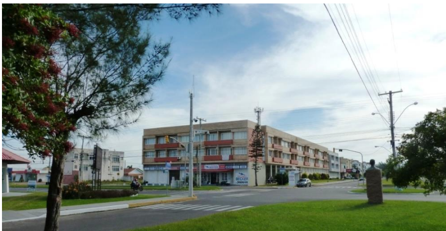
Figura 206. Esquina Avenidas Central e Paraguassu. Busto Ubatuba de Faria no canteiro.
