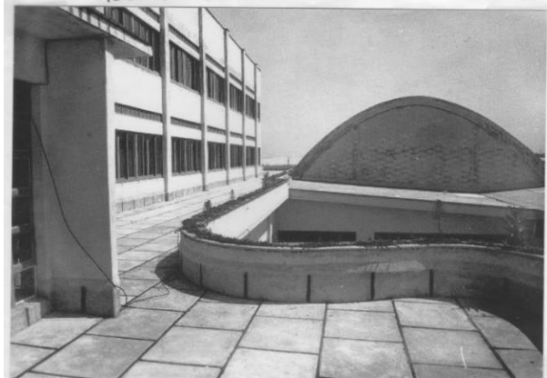
Figura 148. Terraço do segundo pavimento junto à ala de apartamentos com borda sinuosa. Ao fundo, a cobertura do pavilhão social. s/d.
