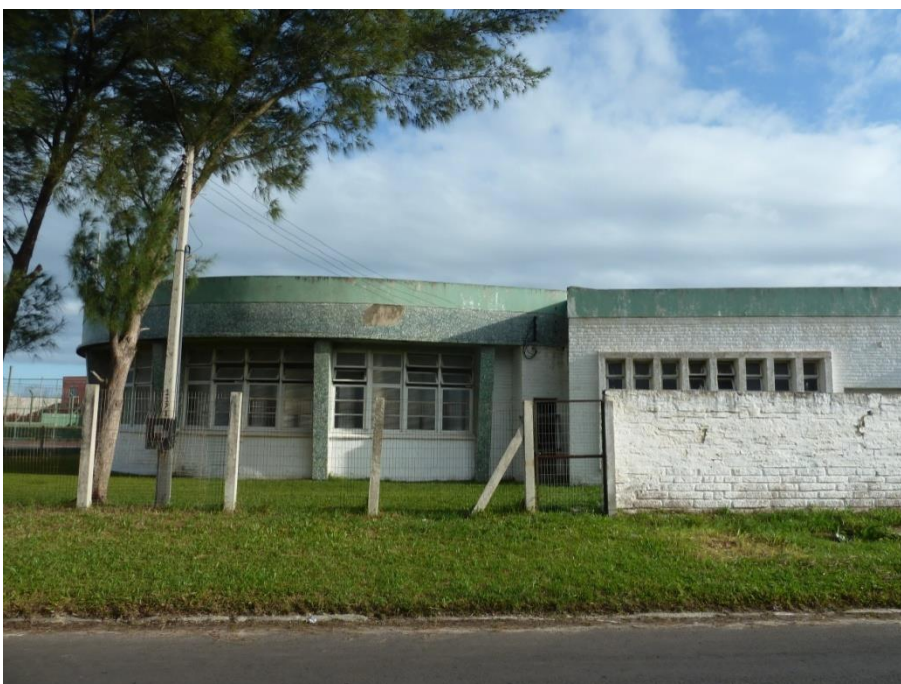
Figura 71. A SAPI construída com alterações, e em estado de abandono em fevereiro de 2014
