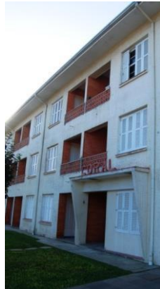
Figura 190. Detalhe da marcação do acesso preservado como projetado. Julho 2015.
