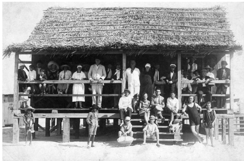
Figura 29. Banhistas na estação do bonde que fazia o transporte, de cerca de 1 km, entre o centro do povoado de Tramandaí e a praia. Construção de madeira com cobertura de "tiririca".
