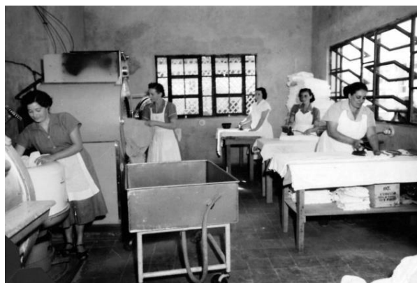
Figura 151. Lavanderia com sistema de esquadrias basculantes.
