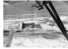
Figura 127. Vista aérea do hotel em construção.
