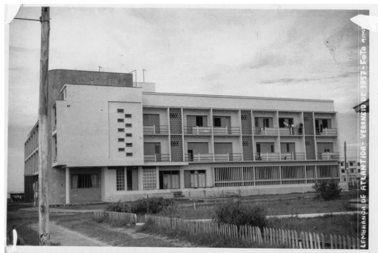
Figura 131. Fachada nordeste do Hotel construído, em foto do mesmo ângulo da foto da maquete.
