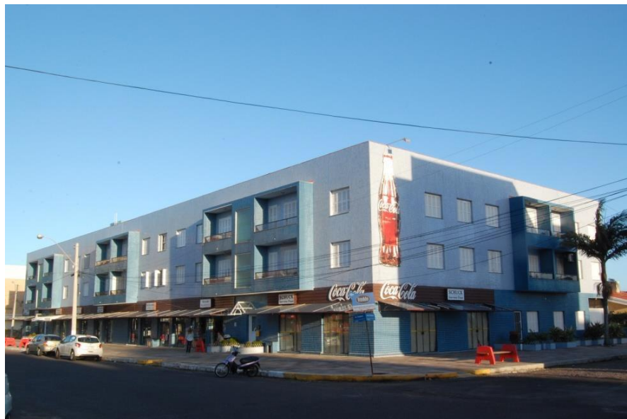
Figura 175. Foto atual da esquina norte. As fachadas tiveram os revestimentos alterados, porém está mantida a solução do conjunto de balcões projetados 4 a 4. Julho 2015.
