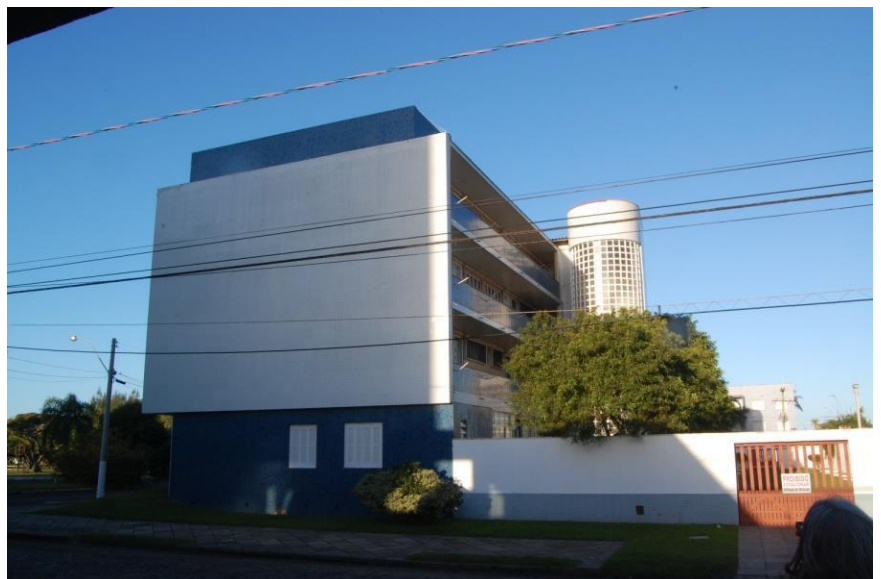
Figura 185. Empenavoltada para rua lateral com térreo ocupado. Detalhe do coroamento/platibanda ecuada. Julho 2015.
