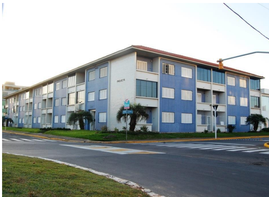
Figura 197. Esquina avenidas Central e Paraguassu. Julho 2015.
