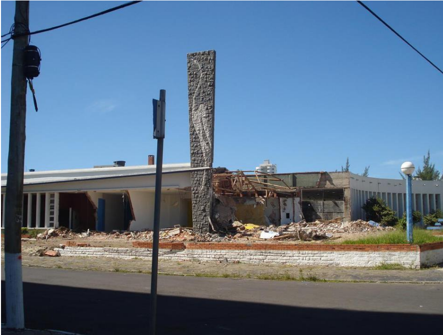
Figura 76. O início da demolição da SAT em abril de 2013.
