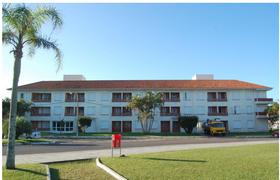
Figura 192. Fachada voltada para a Praça Central. Julho 2015
