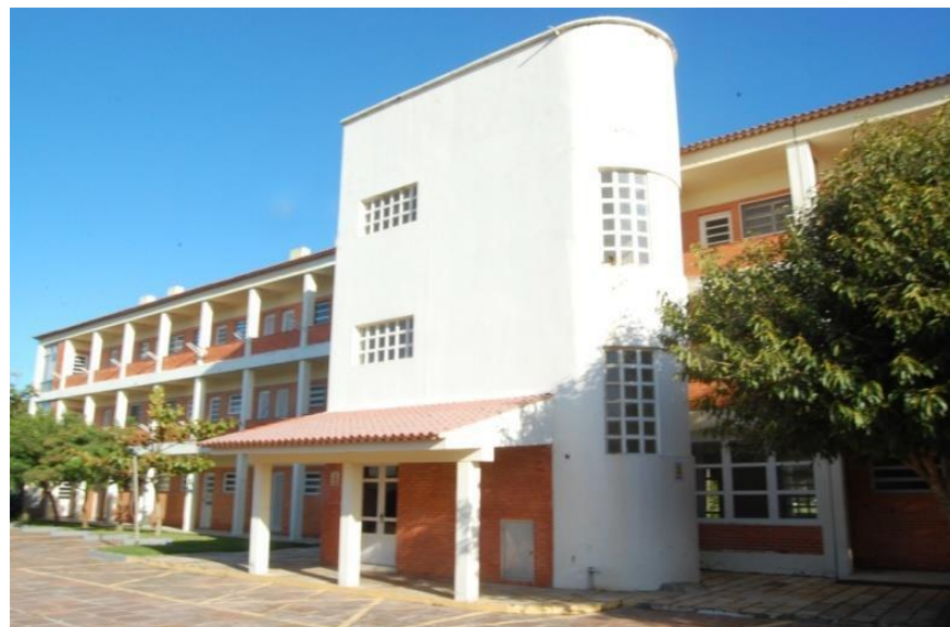
Figura 170. Fachada voltada para o interior da quadra, que mantém o padrão de circulações horizontais abertas, unidas por escada destacada do corpo do prédio.
