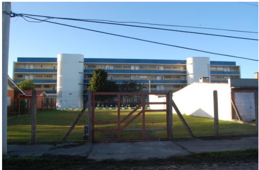
Figura 184. Fachada interna com caixas de escada e circulações horizontais abertas, voltadas para o interior do lote. Julho 2015.
