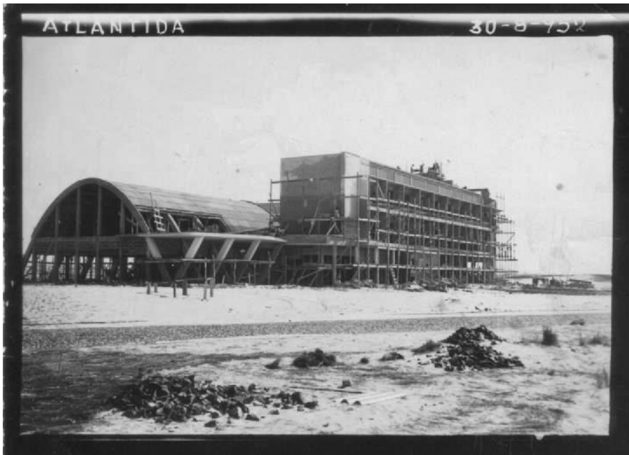
Figura 133. Vista a partir do sul dos dois blocos em construção, 1952.
