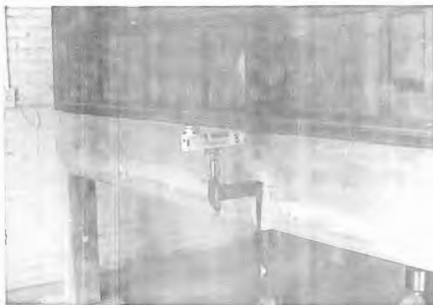
Fig. 3.38 - Detalhe da colocação do clinômetro na lateral da viga
