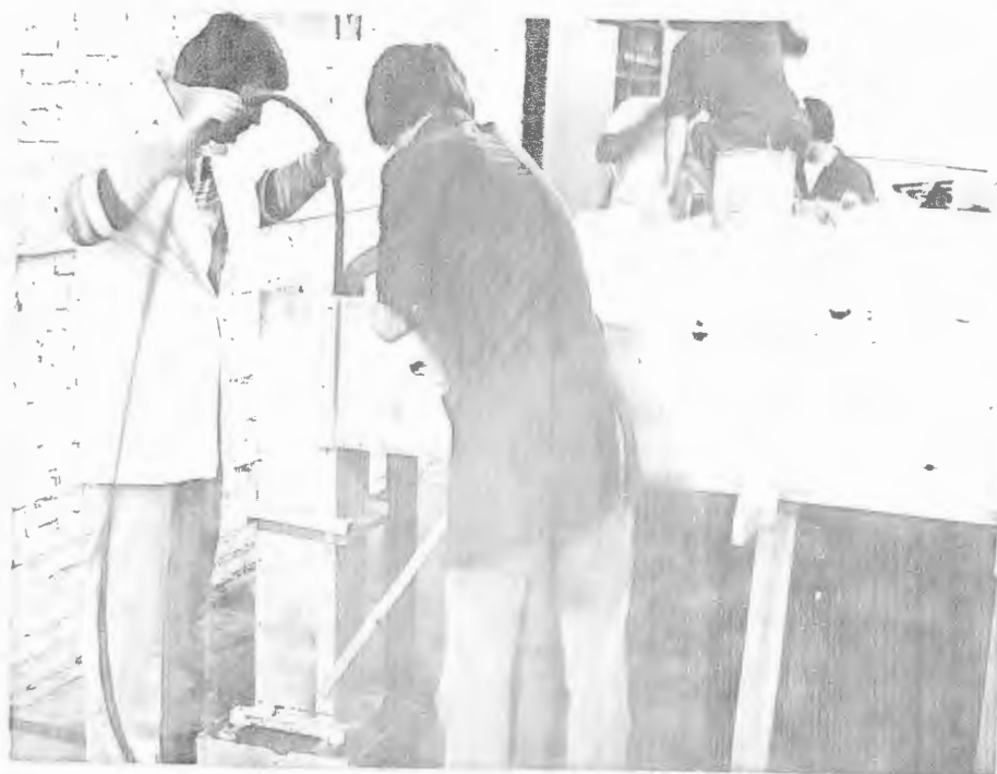
Fig. 3.27 - Concretagem dos pilares
