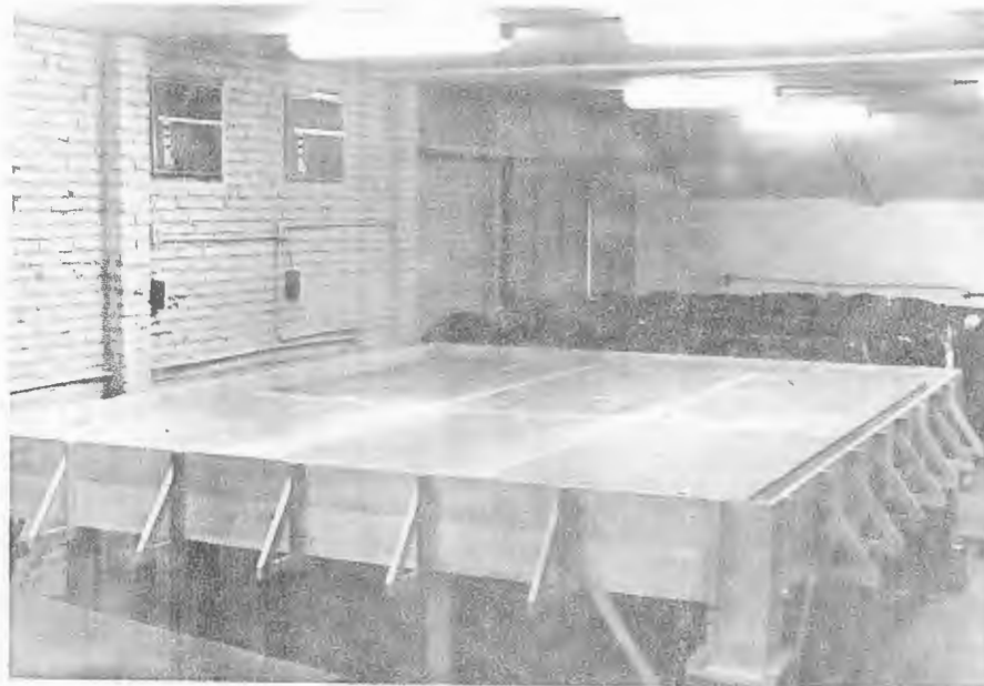
Fig. 3.23 - Formas das vigas e da laje
