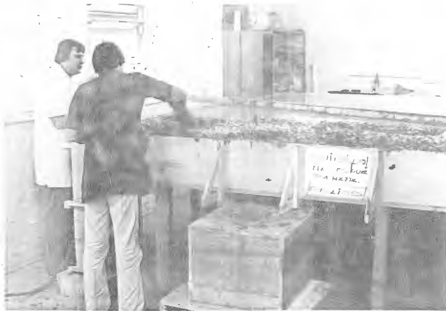
Fig. 3.28 - Concretagem da laje
