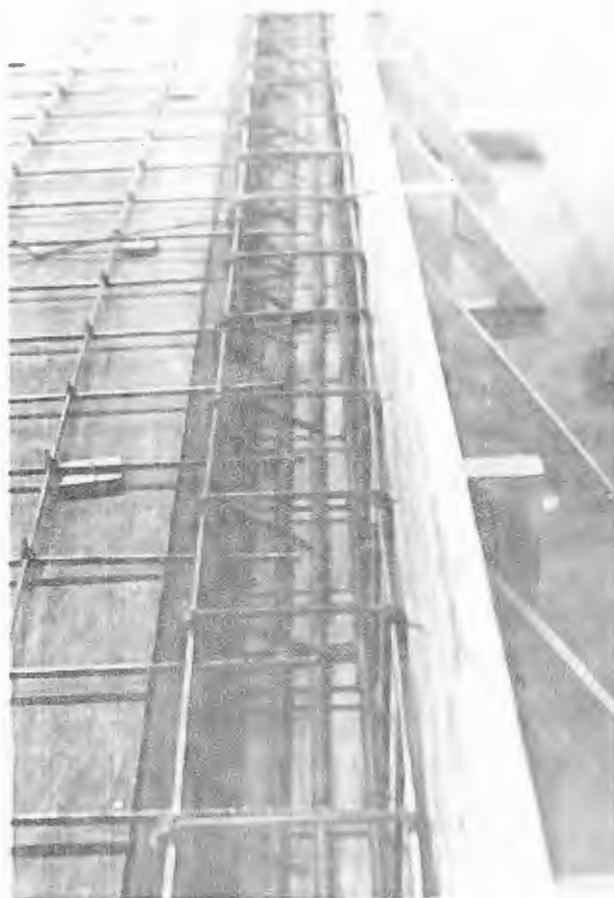
Fig. 3.15 - Viga V_1 = V_2 na forma do protótipo
