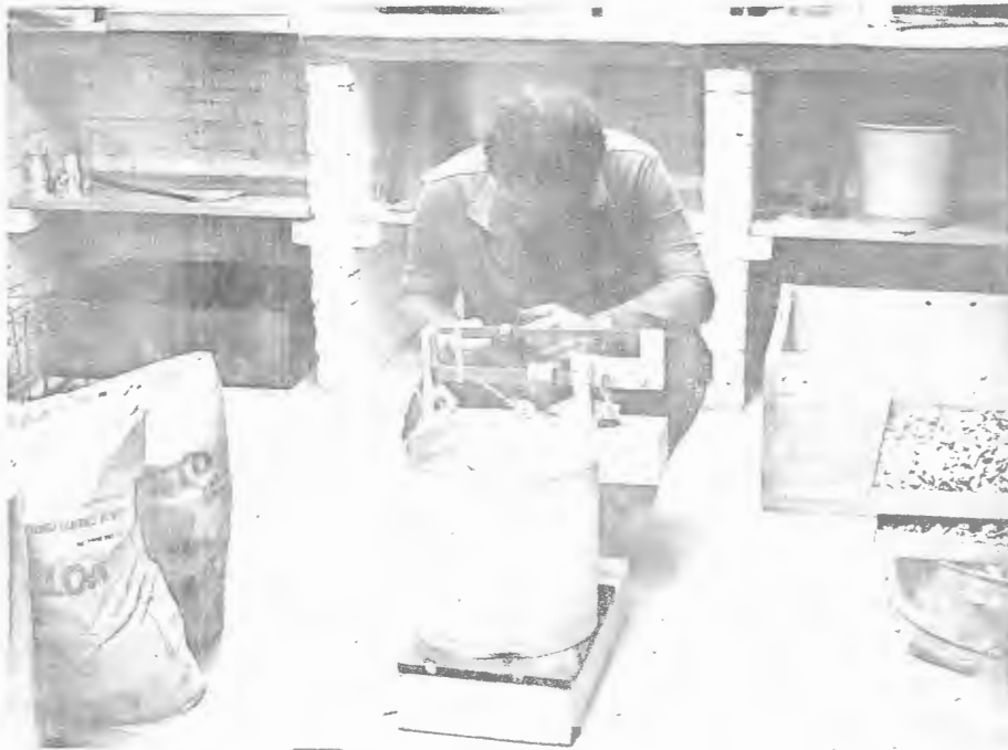
Fig. 3.25 - Dosagem realizada em peso
