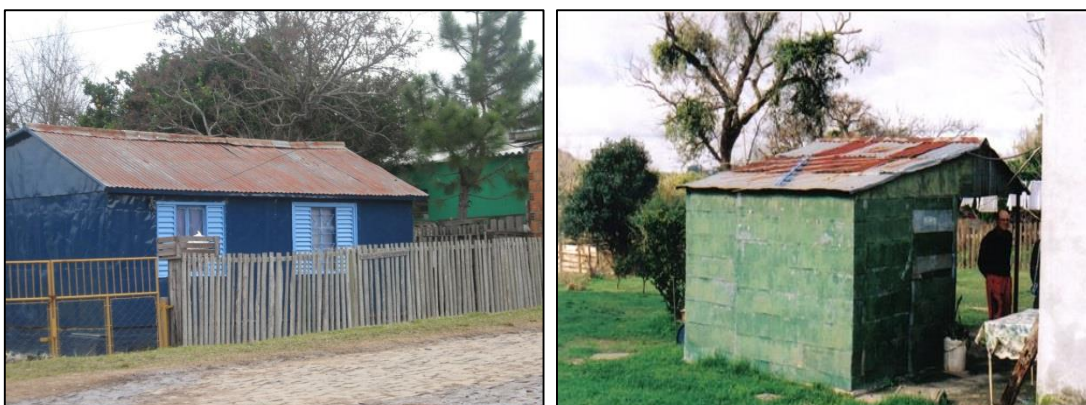
Figuras 63 e 64. Casas de lata no bairro Progresso, próximo ao Frigorífico Armour – Santana do Livramento/RS.
