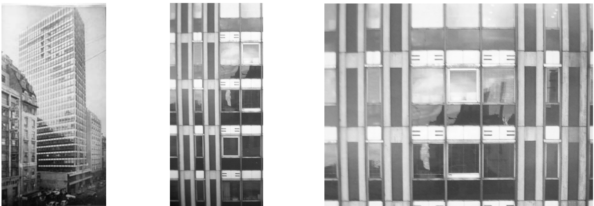
Lâmina 83: Expressão muito homogênea da torre com detalhe expressivo do clube com a escada no trecho final da torre.
