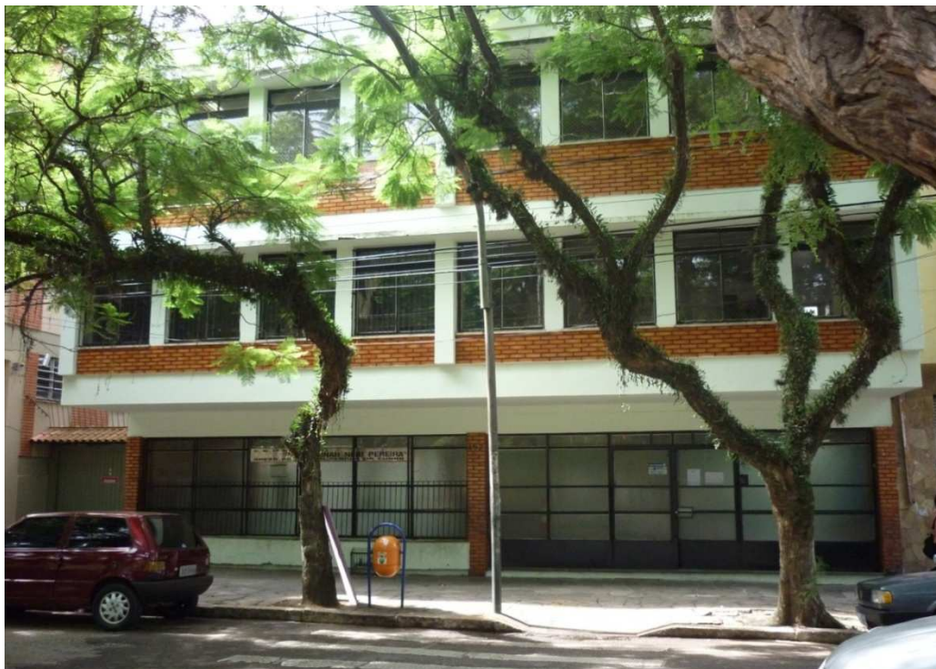
Figura 59. A "porta" na fachada principal da Escola Dináh Neri Pereira, em Porto Alegre-RS
