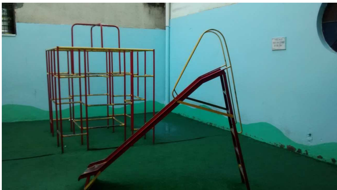
Figura 72. Concluindo a obra da pracinha 1
