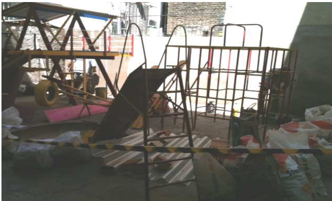
Figura 71. A obra de reforma da pracinha
