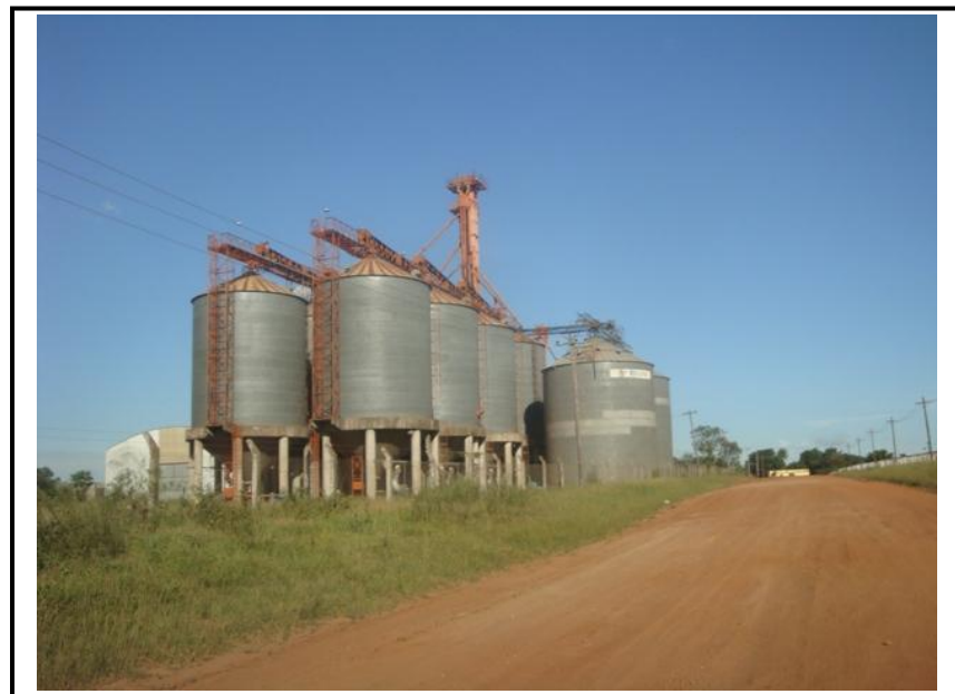
Figura 17 - Engenho de armazenagem de grãos
