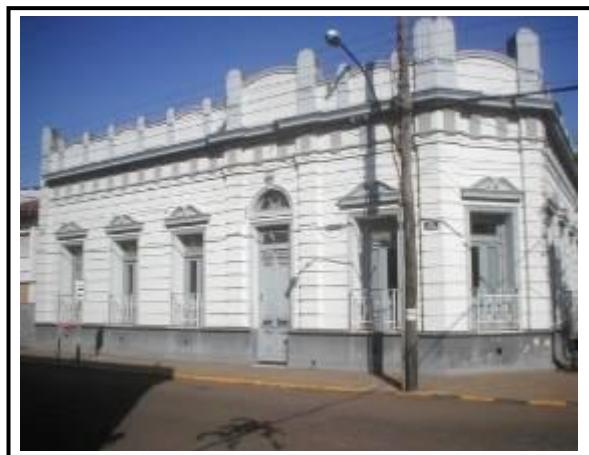
Figura 50 - Residência com arquitetura eclética (São Borja)
