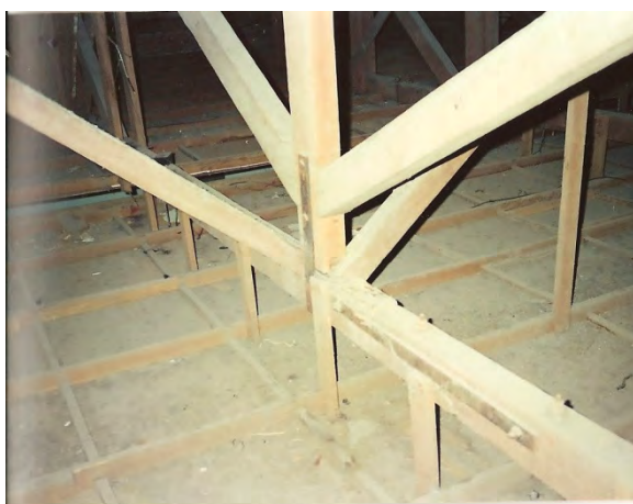
Figura 62 - Cobertura Cine Independência Fonte: SILVEIRA, 2001
