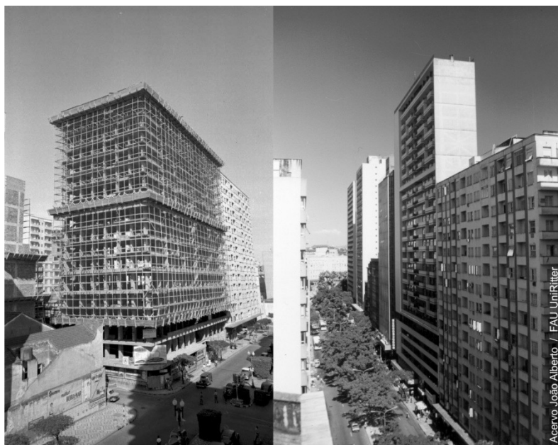
Figura 112 - Edifício Jaguaribe em construção e inserido no contexto urbano Fonte: acervojoaoalberto.blogspot.com.br
