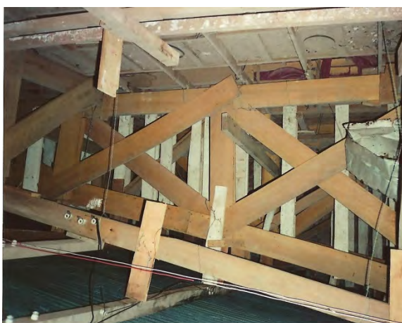
Figura 59 - Cobertura Cine Independência Fonte: SILVEIRA, 2001
