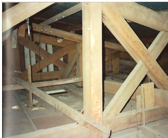
Figura 61 - Cobertura Cine Independência Fonte: SILVEIRA, 2001
