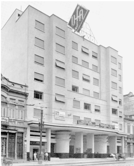
Figura 94 - Fachada UFA Palace Fonte: salasdecinemasdesaopaulo.blogspot.com.br
