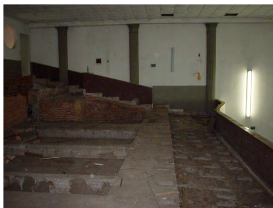
Figura 68 - Estrutura de piso do mezanino em demolição Fonte: PEREYRON, 2004
