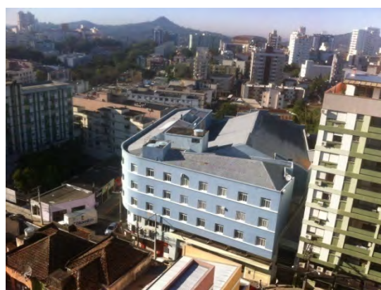
Figura 122 - Cinema Glória na cidade Fonte: A autora, 2015
