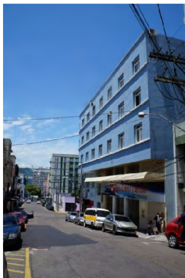
Figura 173 - Fachada Rua Angelo Uglione Fonte: A autora
