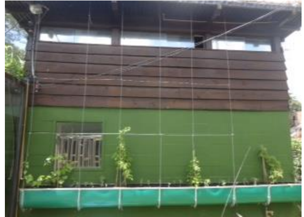
Figura 15: Brise vegetal com cabos de aço instalado na empresa Ecotelhado
