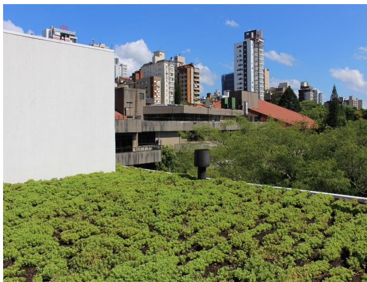
Figura 11: Telhado verde vegetado com boldo ( Coleus barbatus ) após 3 semanas da instalação
