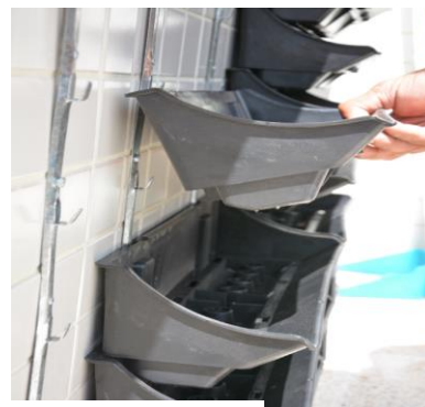
Figura 13: Fixação das cremalheiras na parede para colocação das floreiras do Sistema Jardim Vertical Canguru
