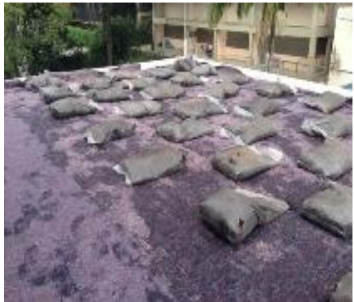
Figura 9: Colocação da membrana de absorção e do substrato
