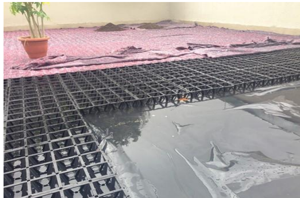
Figura 18: Colocação da membrana de impermeabilização em seguida do sistema laminar médio e da membrana de absorção
