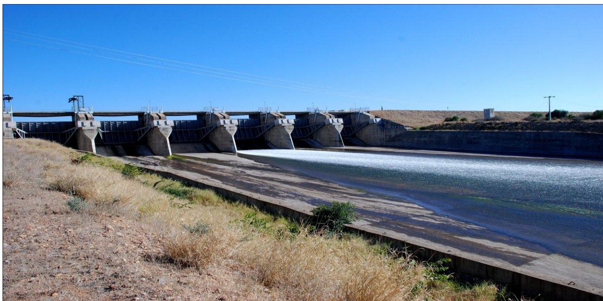
Figura 3.4: Imagem ilustrativa da barragem de Massingir
