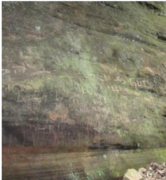
Figura 57. Pichações nas paredes laterais da Cascata das Andorinhas. Foto: do Autor, em 07/11/2014.
