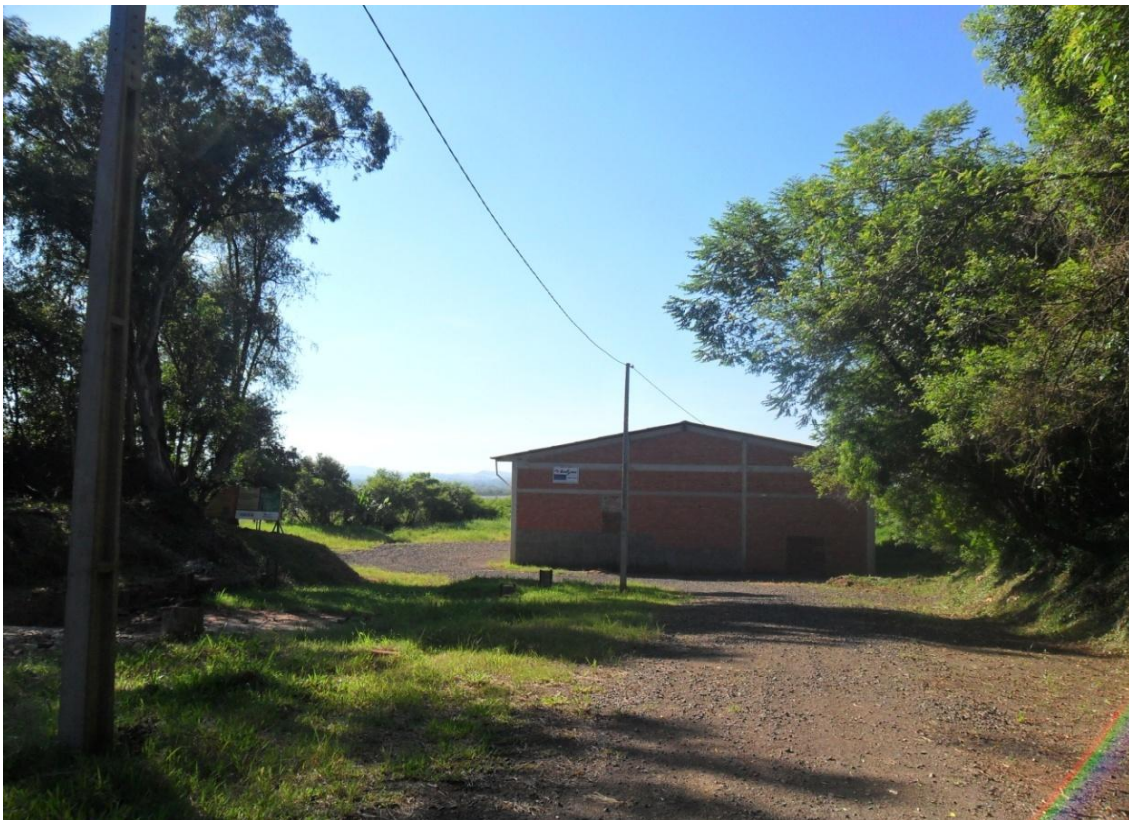
Figura 21: Foto da futura central de beneficiamento do PET em NH, 2015.
