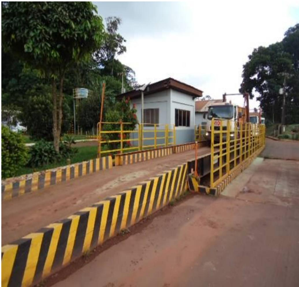
Figura 3 – Balança rodoviária da Central de Materiais Descartáveis (CMD)
