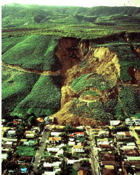
Figura 43. Ruptura circular ocorrida na Califórnia, EUA
