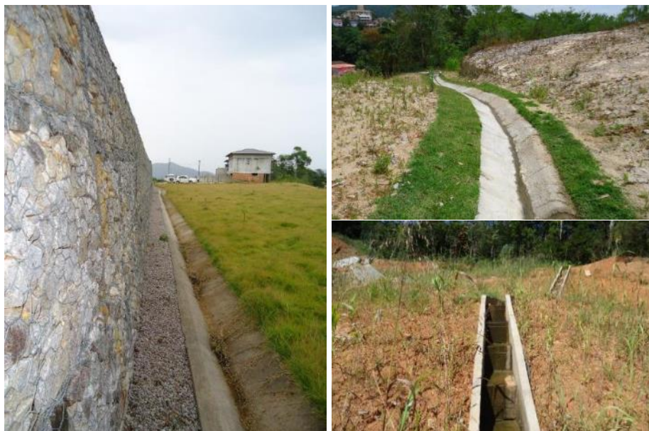
Figura 29: Aspecto das estruturas executadas em julho de 2013.
