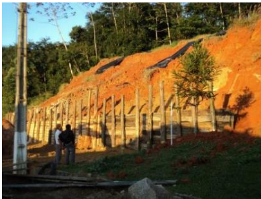
Figura 27: Aspecto da cortina de madeira executada para contenção dos primeiros escorregamentos.
