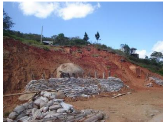
Figura 27: Aspecto da cortina de madeira executada para contenção dos primeiros escorregamentos.
