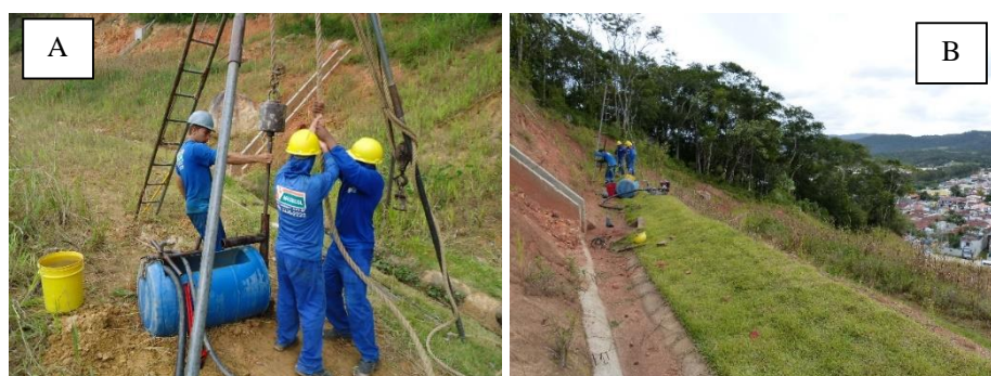
Figura 51: Execução das sondagens SPT.
