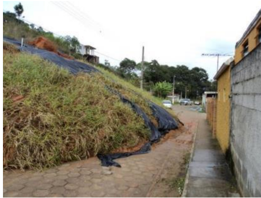
Figura 26: Massa de solo depositada sobre rua do condomínio.
