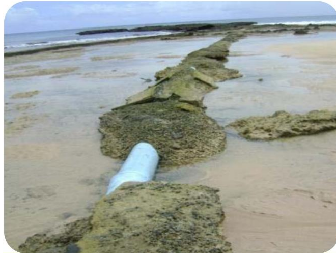
Figura 3.2: Adutora de PVC do sistema de captura da água do mar na praia de Boldró, em Fernando de Noronha. Adaptado de Tavares (2015).
