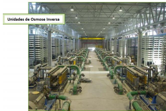
Figura 3.6: Unidades de Osmose Inversa na planta de dessalinização de Torrevieja, Espanha. Adaptado de Mañueco (2015).
