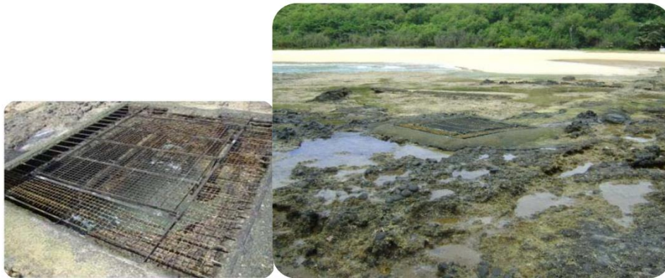
Figura 3.1: Captação da água do mar na praia de Boldró, em Fernando de Noronha, para dessalinização. Adaptado de Tavares (2015).
