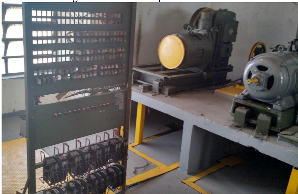
Figura 45. Casa de Máquinas - Elevador E.
