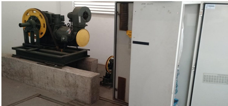
Figura 39. Casa de Máquinas Elevador D.
