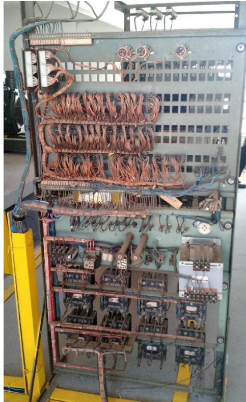
Figura 46. Quadro de Comando - Elevador E.
