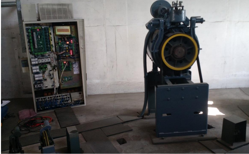
Figura 34. Casa de Máquinas Elevador C.
