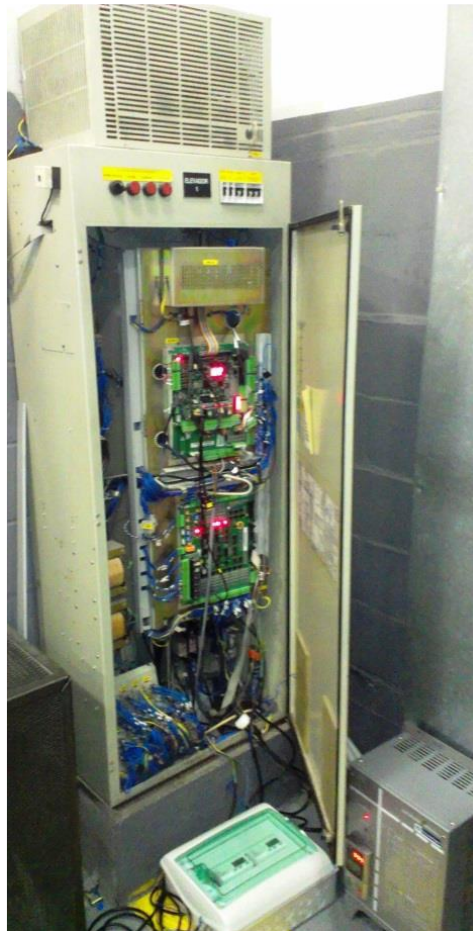
Figura 20. Quadro de comando equipado com unidade regenerativa.
