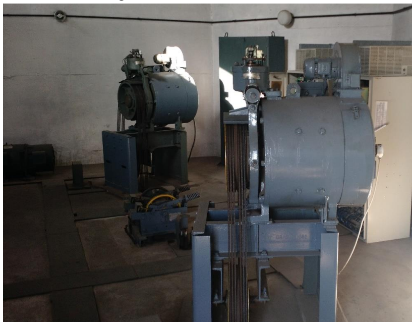
Figura 36. Motor do Elevador C.
