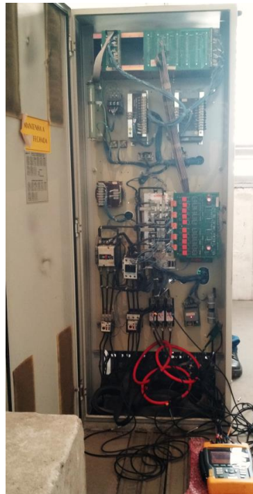
Figura 41. Quadro de Comando Elevador D, Lado 2.
