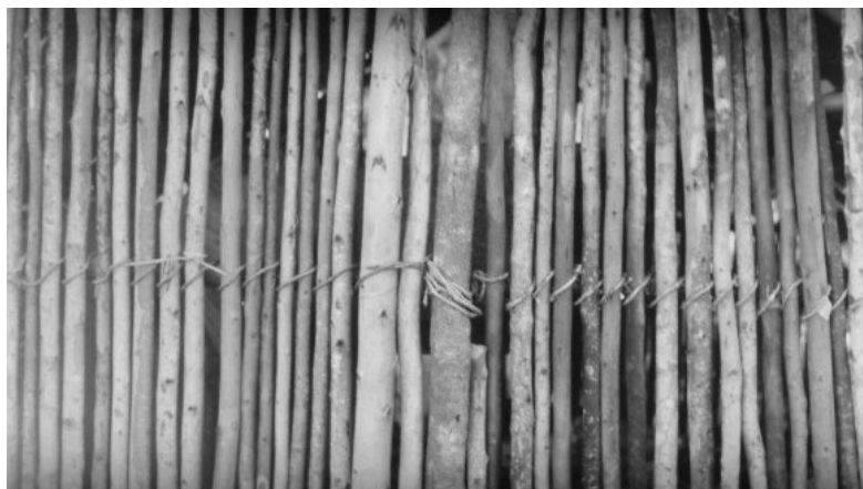
Fig.15: Amarração – estilo tecnológico aplicado à opy
