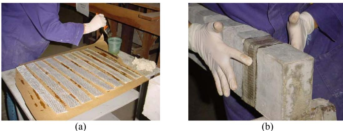
Figura 7.10: (a) aplicação de resina saturante e (b) colagem de um reforço com tecido de fibra de vidro
