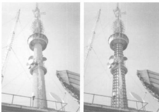
Figura 2.13: antena da TV Globo do Rio de Janeiro, RJ. Antes e depois da execução do reforço (MACHADO, 2002)
