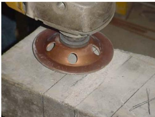
Figura 7.8: preparação do substrato de concreto com esmerilhadeira
