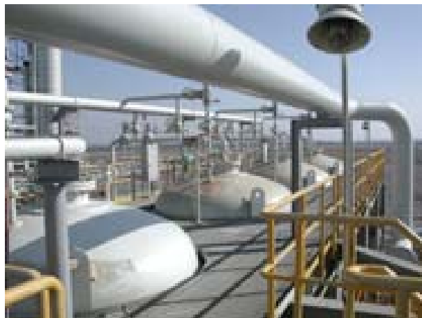
Figura 7: Reator utilizado para geração de olefinas ramificadas através do processo Dimersol
