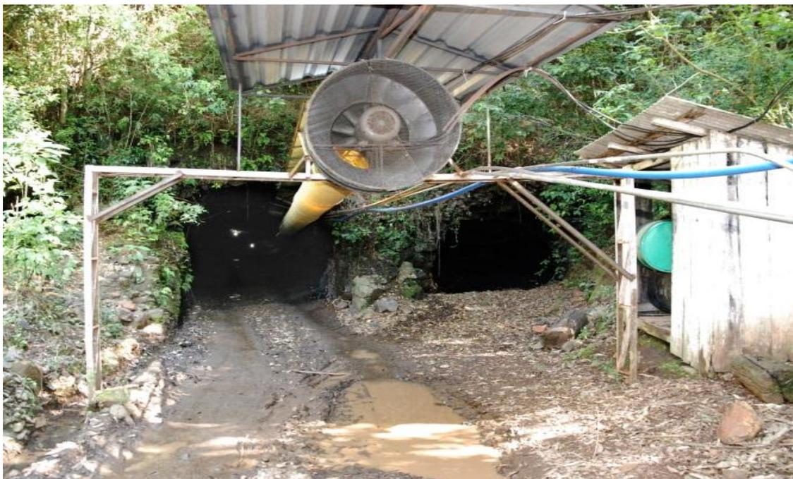
**Figura 7.** Exaustor de ar responsável pela troca de ar interior, pelo ar exterior.
