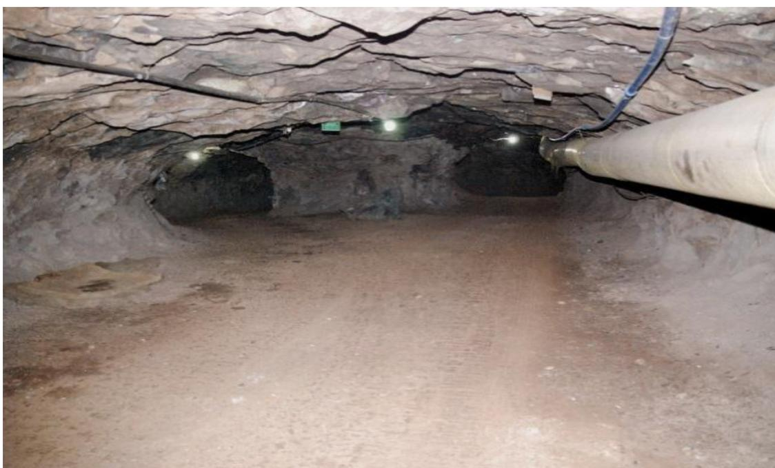
**Figura 8.** Altura e largura correta das galerias horizontais. Iluminação adequada, fornecimento de energia, água e ventilação.
