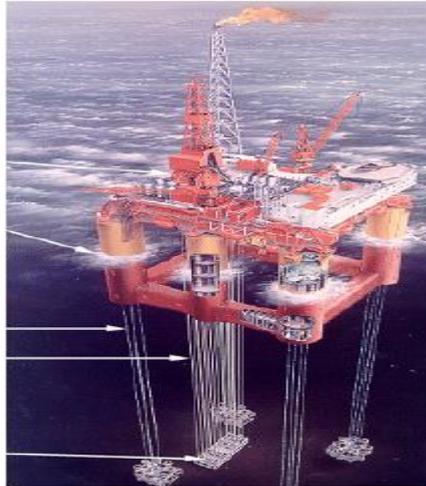
Figura 5 – Plataforma de pernas tensionadas (MONTEIRO, 2008).
