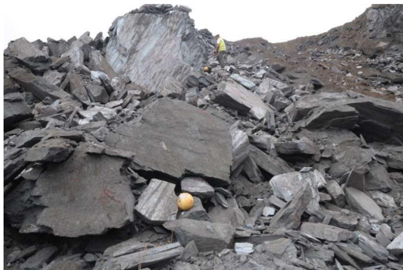
Figura 16 - Desmonte com grande quantidade de fragmentos acima do tamanho desejado na parte superior da pilha.
