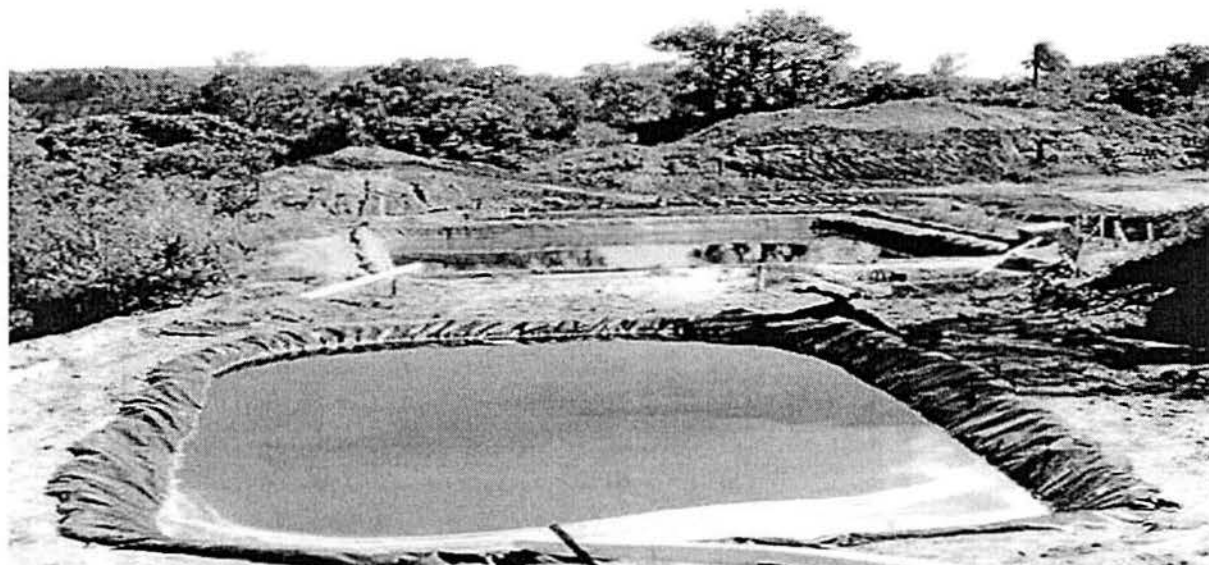
Figura 3: Vista geral dos percolados gerados na Central Lomba Grande ( 1999)
