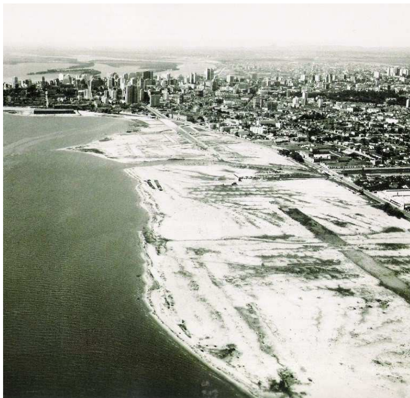
Figura 15 – As obras de aterro, iniciadas em 1959.
