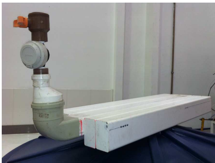
Figura 61: conjunto de condutores ligados ao hidrômetro e à válvula
