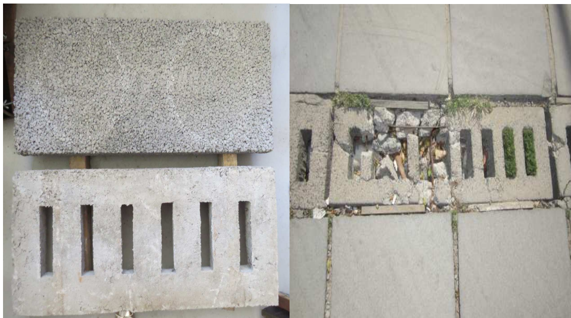
Figura 57: vista superior de elementos em concretos permeável, acima à esquerda, e convencional, abaixo à esquerda e à direita
