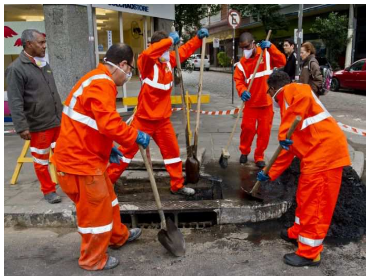
Figura 10: serviços de reconstrução e complementação pluvial (PORTO ALEGRE, 2005b)
