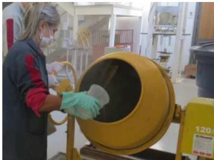
Figura 32: fabricação de concreto permeável através da mistura na betoneira de, respectivamente, pedrisco, parte da água, cimento e o restante da água
