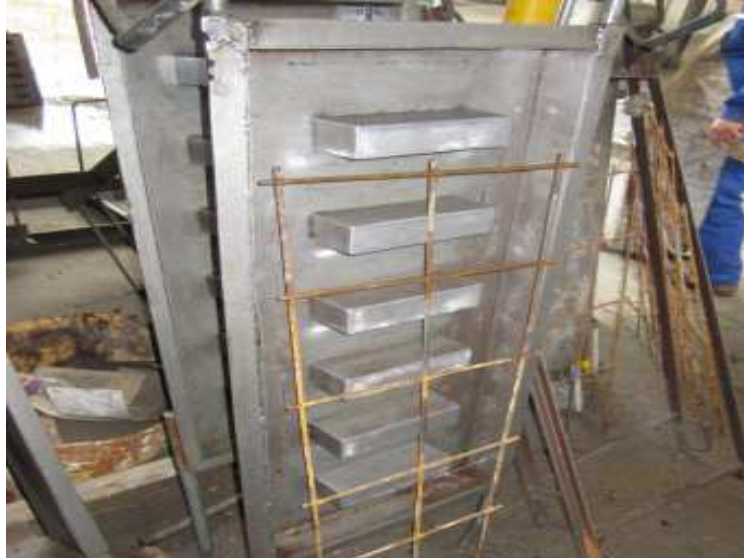
Figura 8: armaduras de reforço na confecção dos elementos fabricados no DEP
