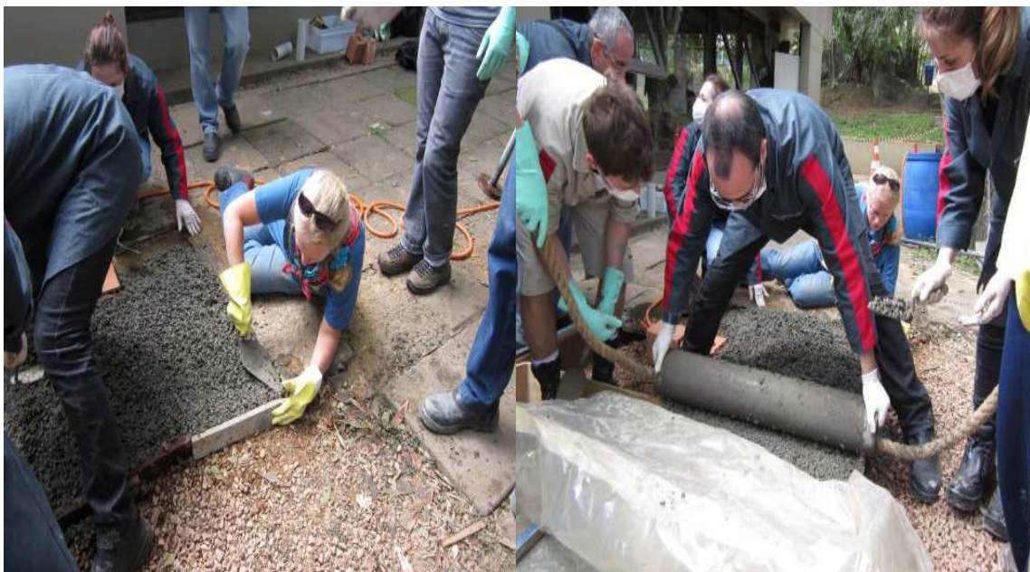
Figura 11: execução de piso experimental no LEME
