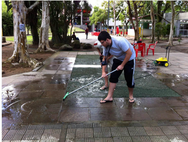
Figura 15: remoção de excesso de água após limpeza de pavimento de concreto permeável
