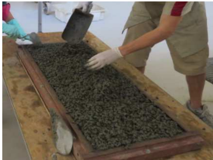
Figura 33: moldagem de placa de concreto permeável com todo o material de uma betonada
