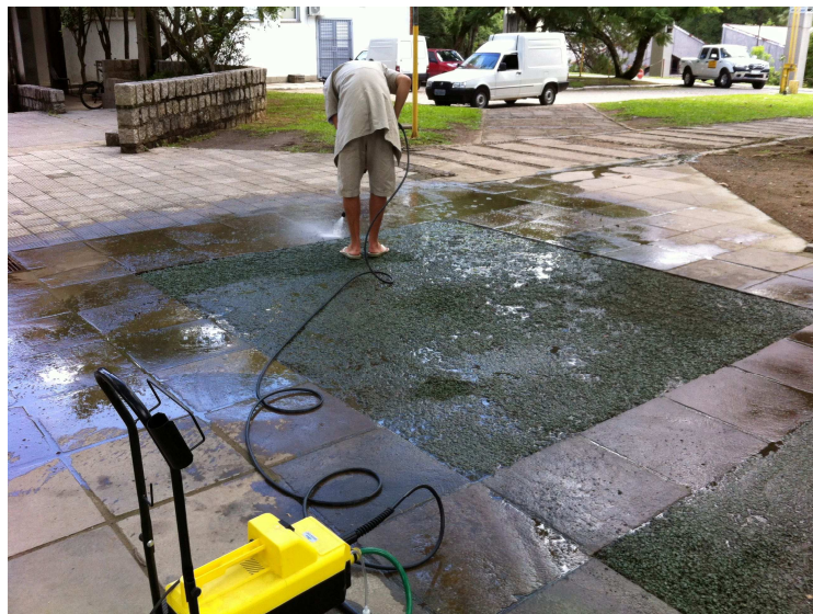
Figura 14: limpeza com água de alta pressão jorrada em pavimento piloto de concreto permeável
