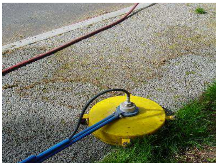
Figura 13: limpeza do entorno de via em concreto permeável (PERVIOUS CONCRETE PAVEMENT, 2012)
