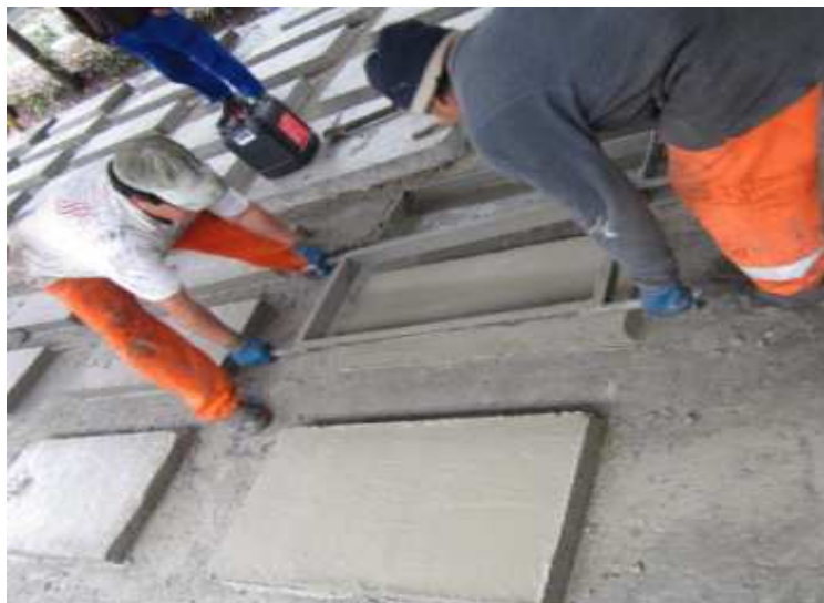
Figura 9: concretagens realizadas de forma artesanal sobre o piso do DEP
