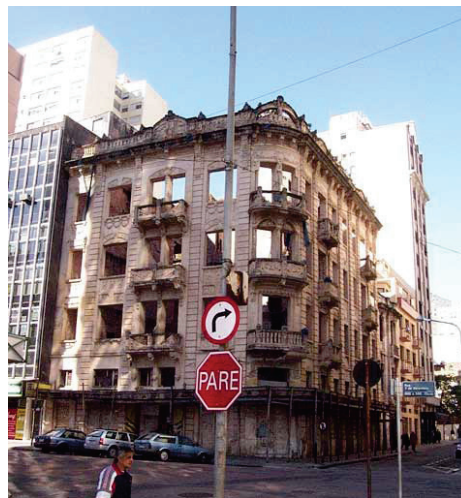
Foto da fachada, início da década de 2000 (fonte: PROCEMPA)
