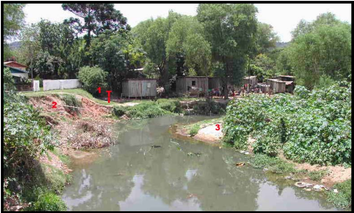
Figura 17: Área de Risco a dinâmica fluvial - Ocupação junto a rua Pedro Alvarez Cabral:(1 – Desnível em relação a margem do canal; 2 – Erosão na margem direita e 3 – vegetação cobrindo depósitos de acumulação.) Oliveira (3/2003)
