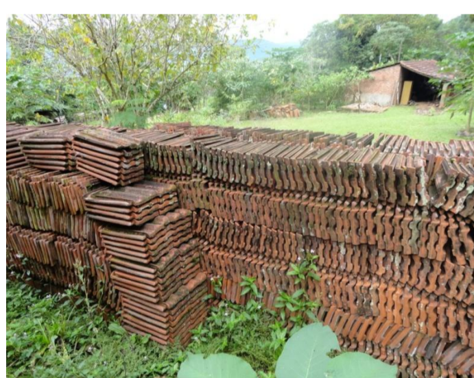
Fig. 3: Material remanescente da antiga construção do local e que será incorporado ao novo projeto e configuração do espaço.
