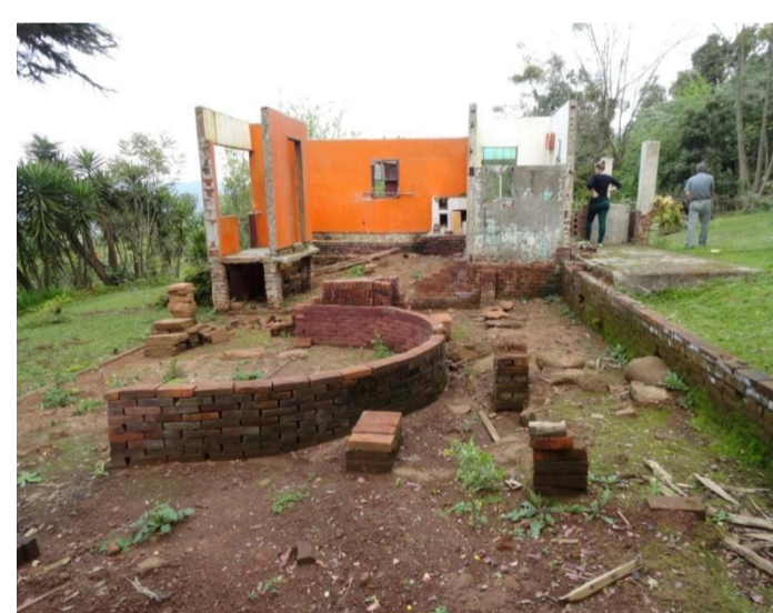
Fig. 4: Paredes preservadas da antiga residência que estarão compondo o projeto da sede do CERES. Ao lado vemos alguns dos tijolos cerâmicos que serão reutilizados no banheiro.
