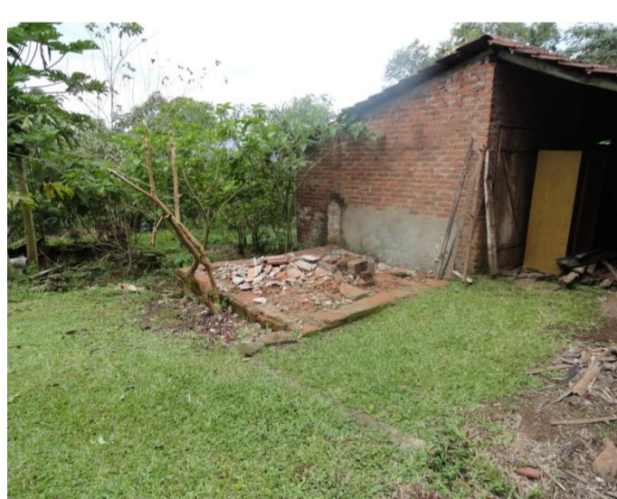
Fig. 2: Fachada leste do estábulo e remanescentes da fundação que será usada para o banheiro com separação de águas.
