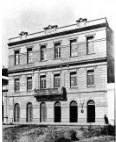
Imagem 20: Fachada Casarão Wanderley, Baís & Cia. Início do séc. XX.
