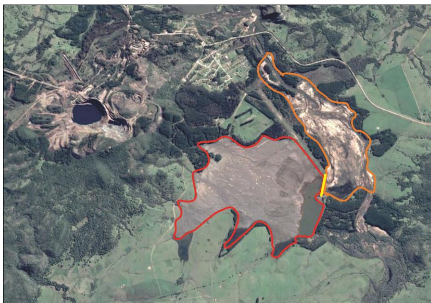
Figura 94: Barragem de rejeito (vermelho), taipa que sofreu rompimento (amarelo) e material ejetado no Arroio João Dias (laranja).
