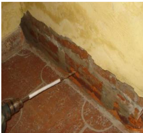
Figura 13 – Execução dos furos
