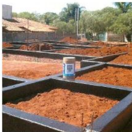
Figura 7 – Impermeabilização dos baldrame com emulsão asfáltica
