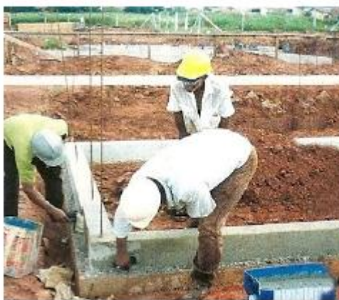
Figura 6 – Impermeabilização dos baldrame com argamassa polimérica
