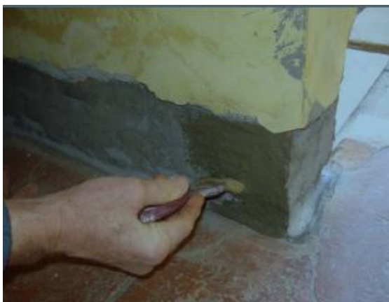
Figura 15 – Aplicação de argamassa impermeabilizante
