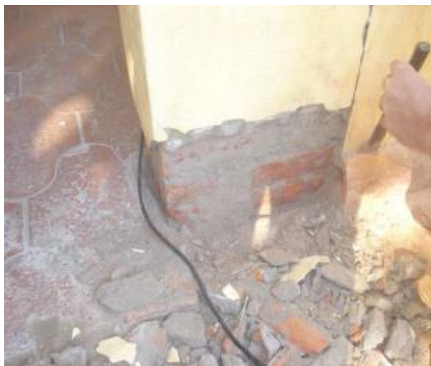
Figura 12 – Retirada do revestimento da parede
