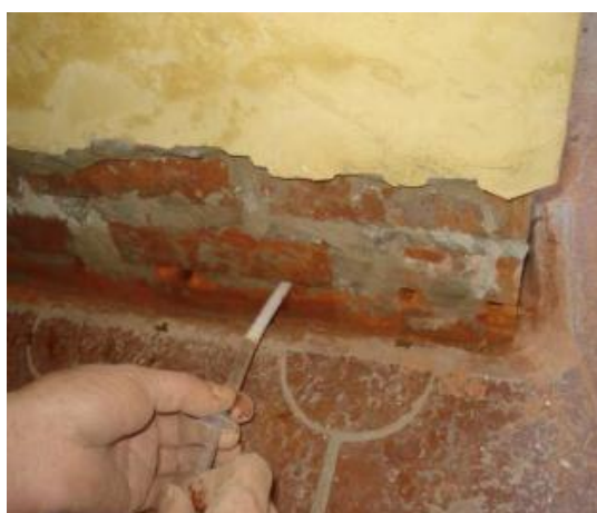
Figura 14 – Aplicação do impermeabilizante
