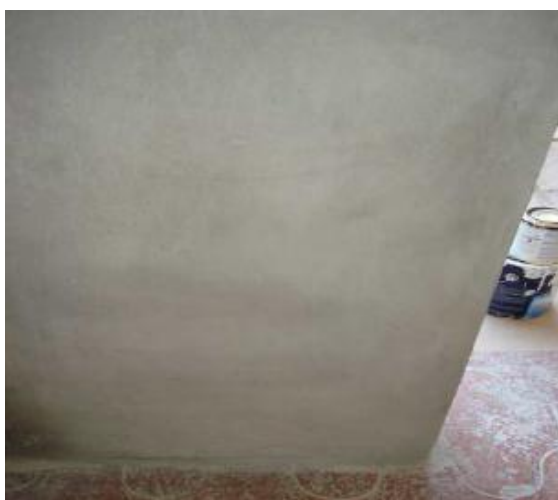
Figura 16 – Parede já revestida após aplicação do produto
